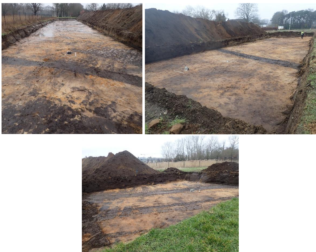
Figuur 8: Overzichtsfoto's van werkput 2. (© Indar bvba)
