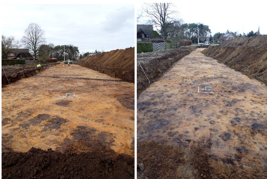
Figuur 10: Overzichtsfoto's van werkput 4. (© Indar bvba)
