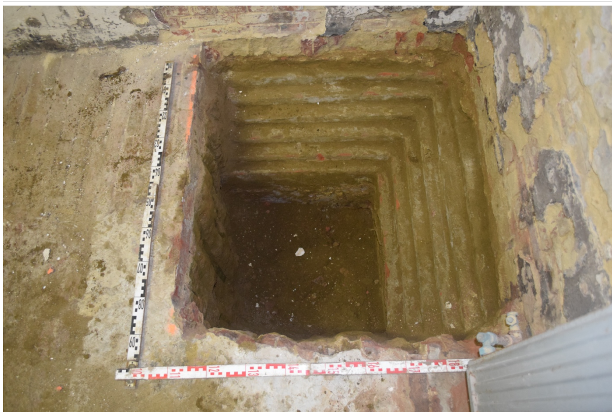
Fig. 2.6: Getrapte funderingsvoet van put 3 aan een binnenmuur.
