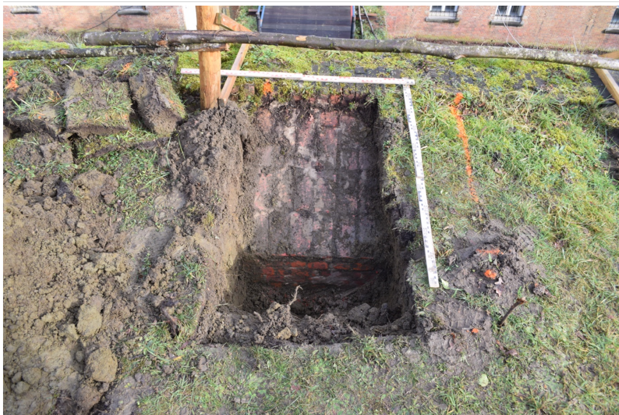
Fig. 2.10: Verbreding van de steunmuur bovenaan, in put 6, vlak onder de zoden.
