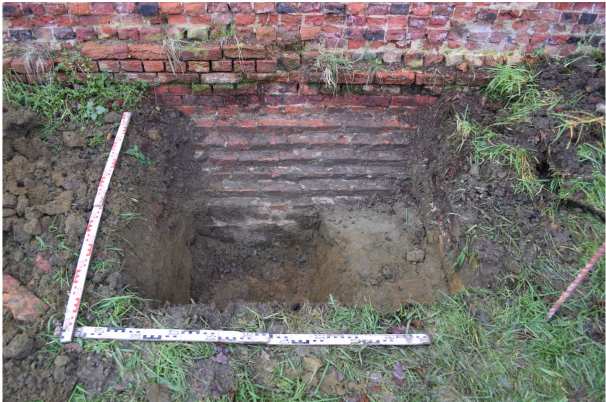
Fig. 2.9: Getrapte funderingsvoet onderaan de steunmuur in put 7.
