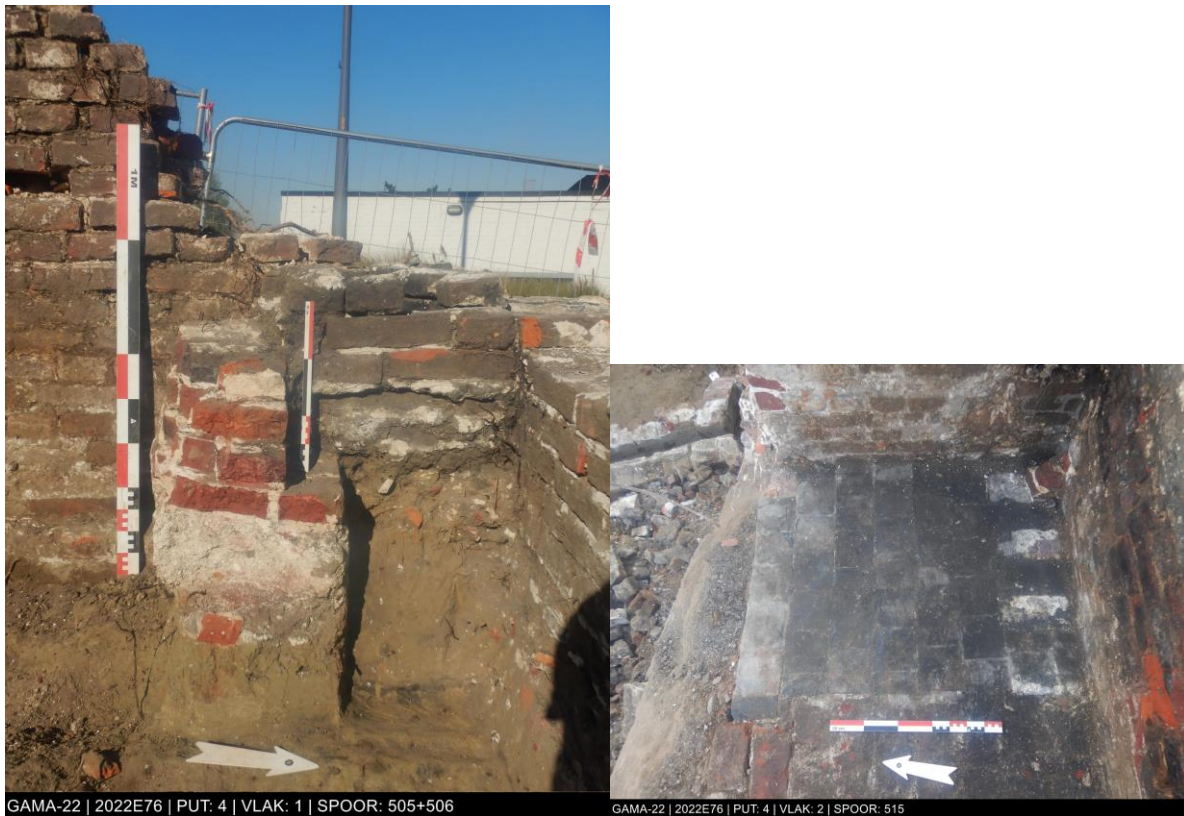
Figuur 182: Zicht op de binnenzijde van de schoorsteen (S505) en S515 (rechts).
