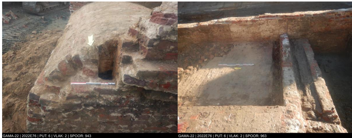
Figuur 159: Zicht op de kleine opening in de noordoostelijke hoek van de beerput en S963 (links)
