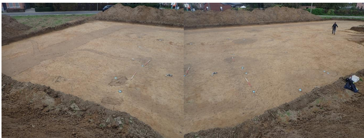
Figuur 33: Zicht op het noordwestelijk en noordoostelijk gedeelte van gracht S1. © Indar bv
