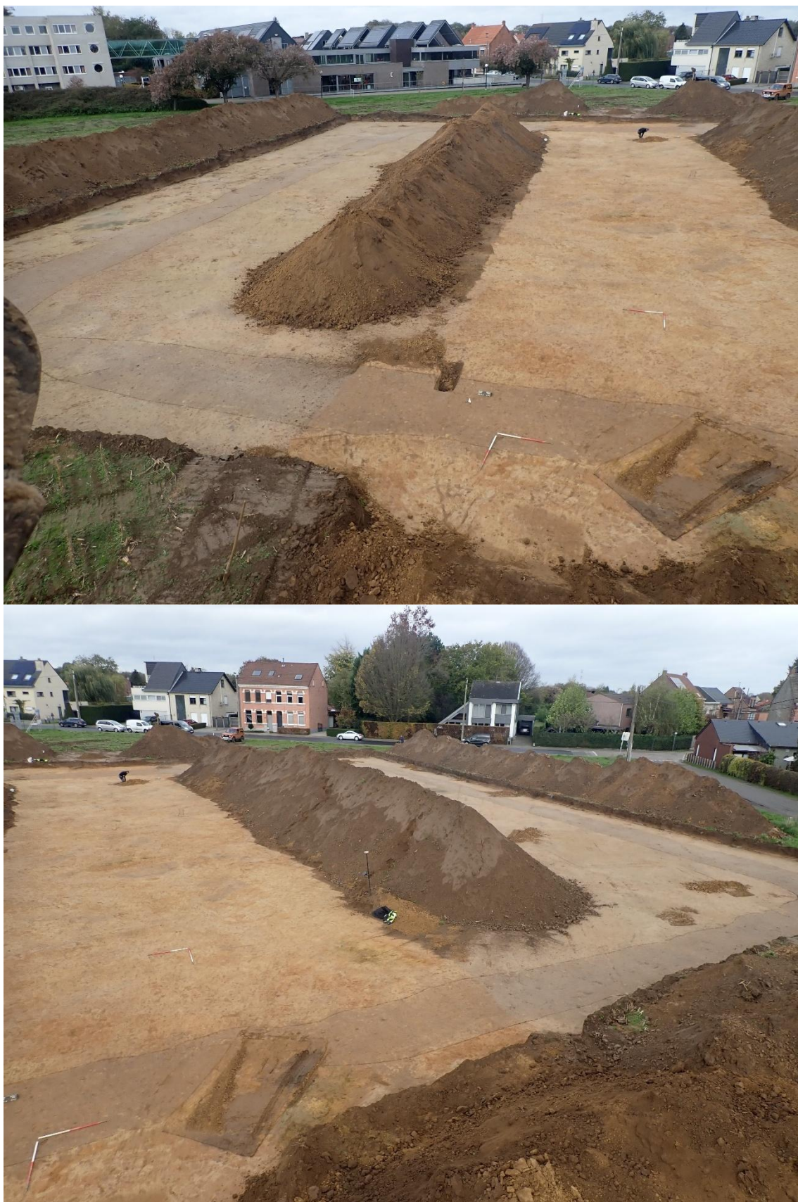
Figuur 37: Totaal overzicht van gracht S1. © Indar bv
