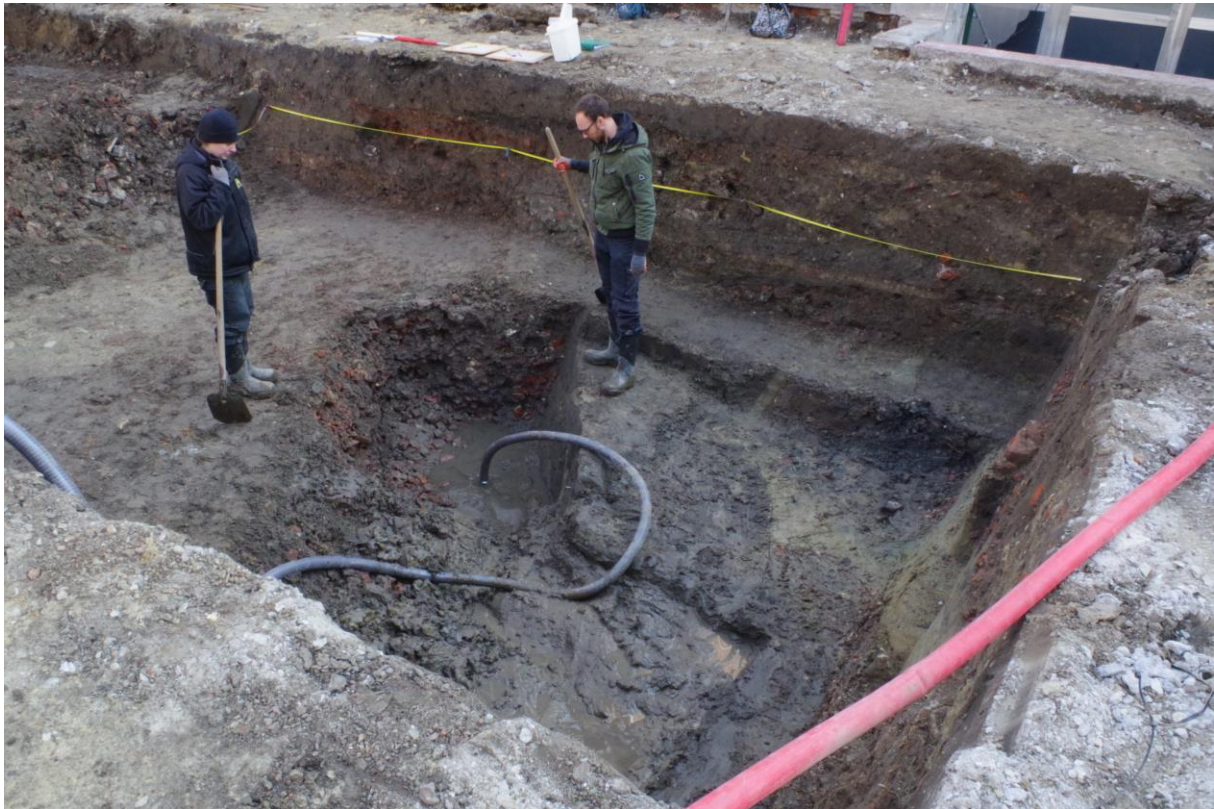
Fig. 38: Het leegpompen van een puinpakket.
