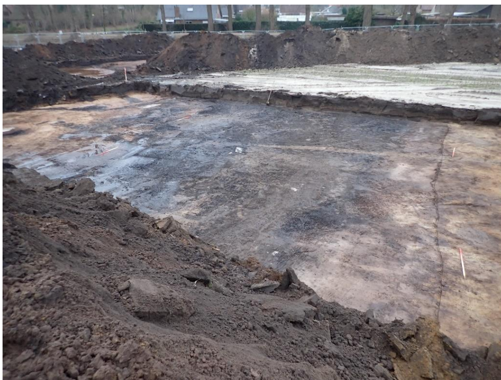
Figuur 114: Zicht op de depressie in werkput 2, S41 (© J. Verrijckt bv).
