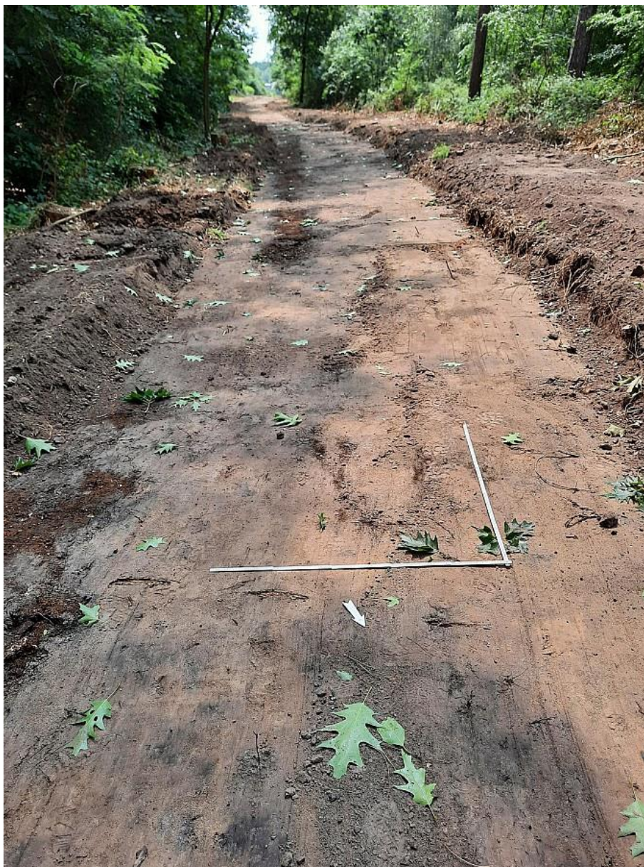
Figuur 40: Afgraven tot op diepte ter hoogte van het westelijke pad.
