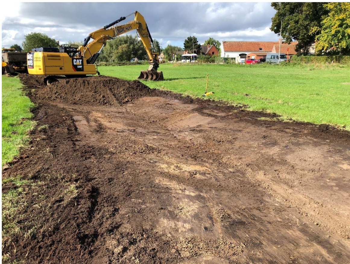
Figuur 30: Zandigere ophoging in walgracht 3 in noordelijk deel. Foto richting W.
