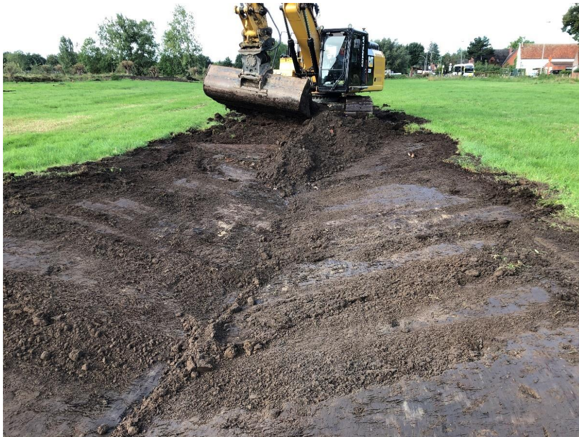
Figuur 29: Dikker venig pakket in walgracht 3 in noordelijk deel. Foto richting W.
