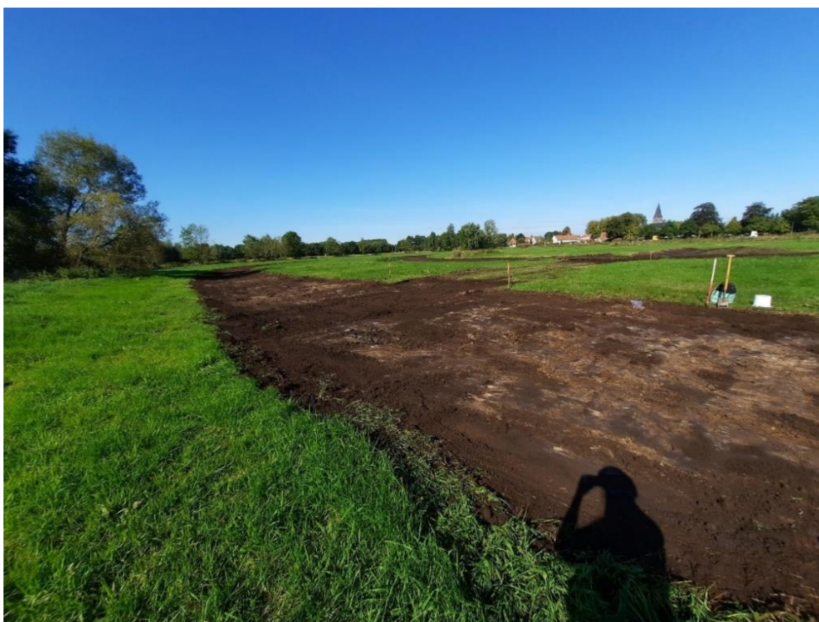
Figuur 27: Overzicht uitdieping walgracht 3 in zuidelijk deel. Foto richting NW.
