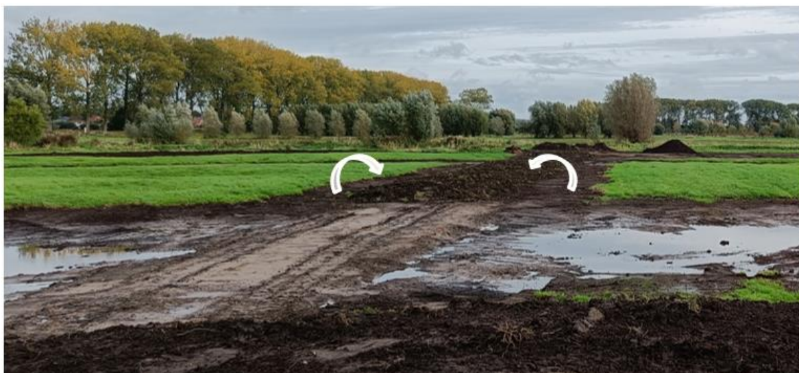
Figuur 9: Afgegraven trambeding ter hoogte van walgracht 1. Foto richting oosten. Reconstructie van de trambeding met zoden van naast de bedding en grond uit gracht.
