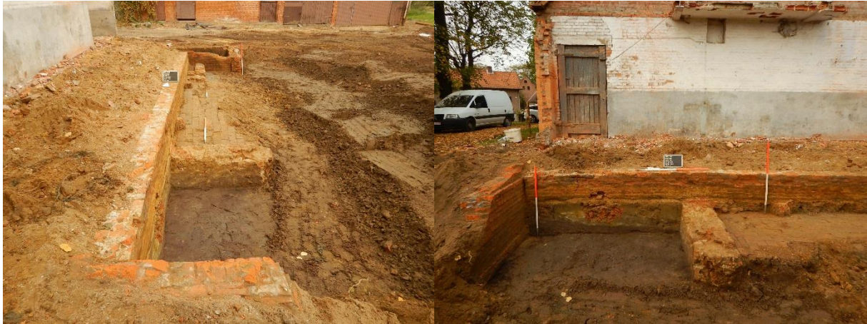
Figuur 42: Overzicht WP3, met oudere muurresten centraal (links) en oude muren onder dwarsmuur vM3/zandbed/puinlaag, met te behouden bebouwing op de achtergrond (rechts)
