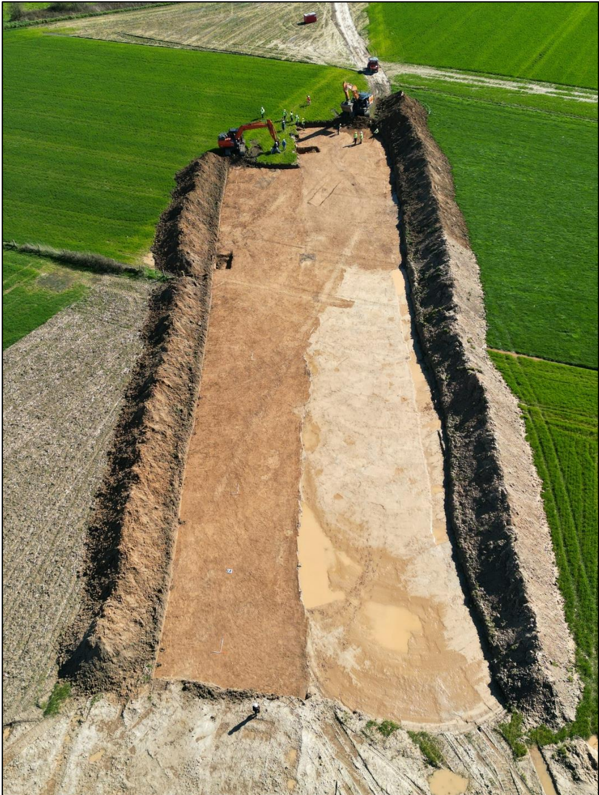
Figuur 22: Drone-opname van Zone 4C tijdens de aanleg (ABO nv 2023)
