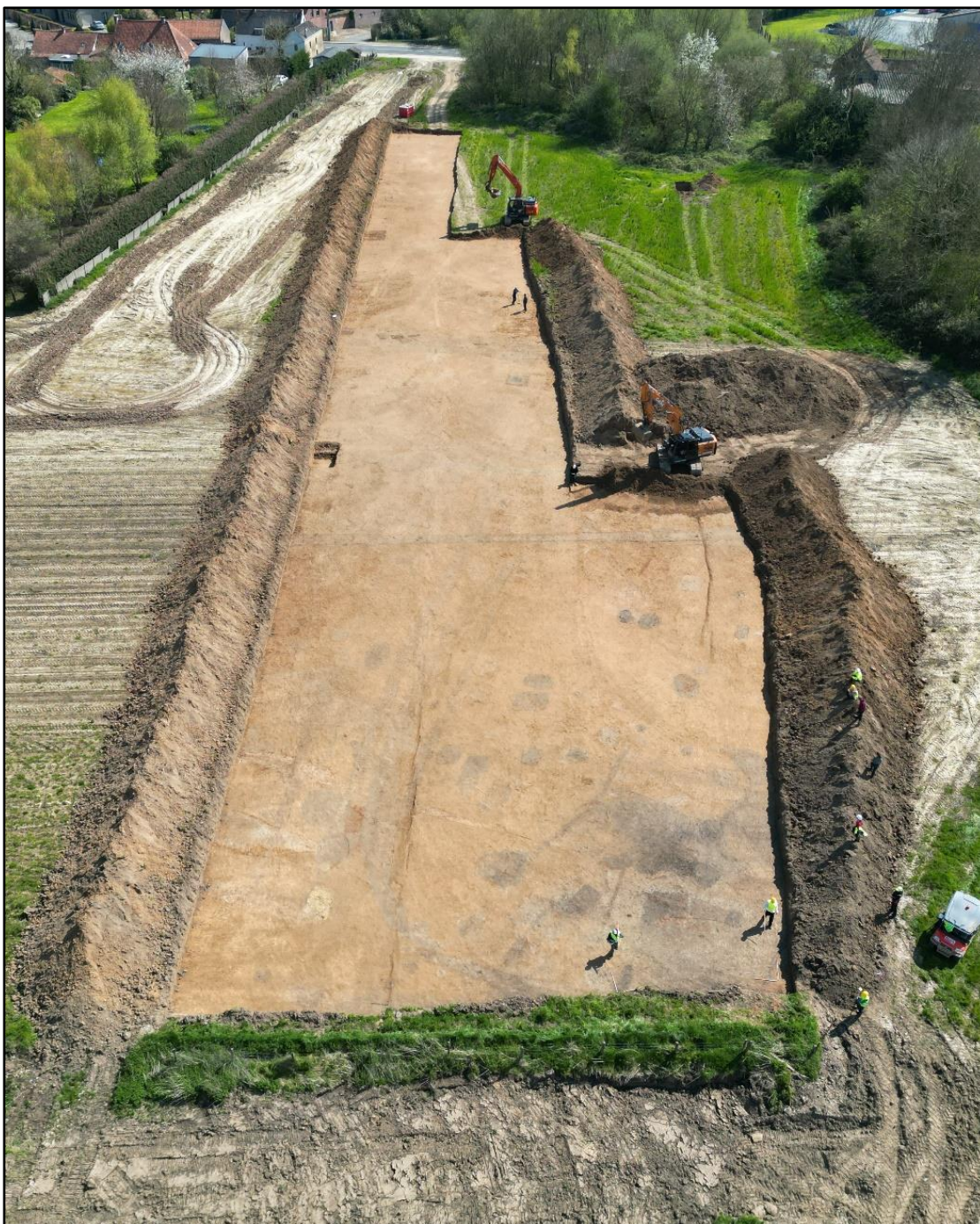
Figuur 27: Drone-opname van Zone 4E vanuit het zuiden tijdens de aanleg (ABO nv 2023)
