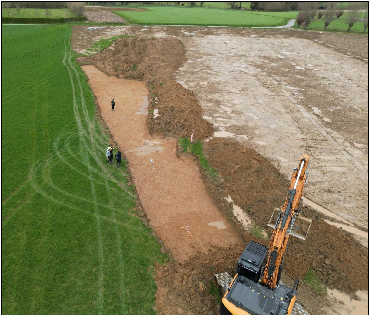
Figuur 19: Drone-opname van Zone 4B tijdens de aanleg (ABO nv 2023)
