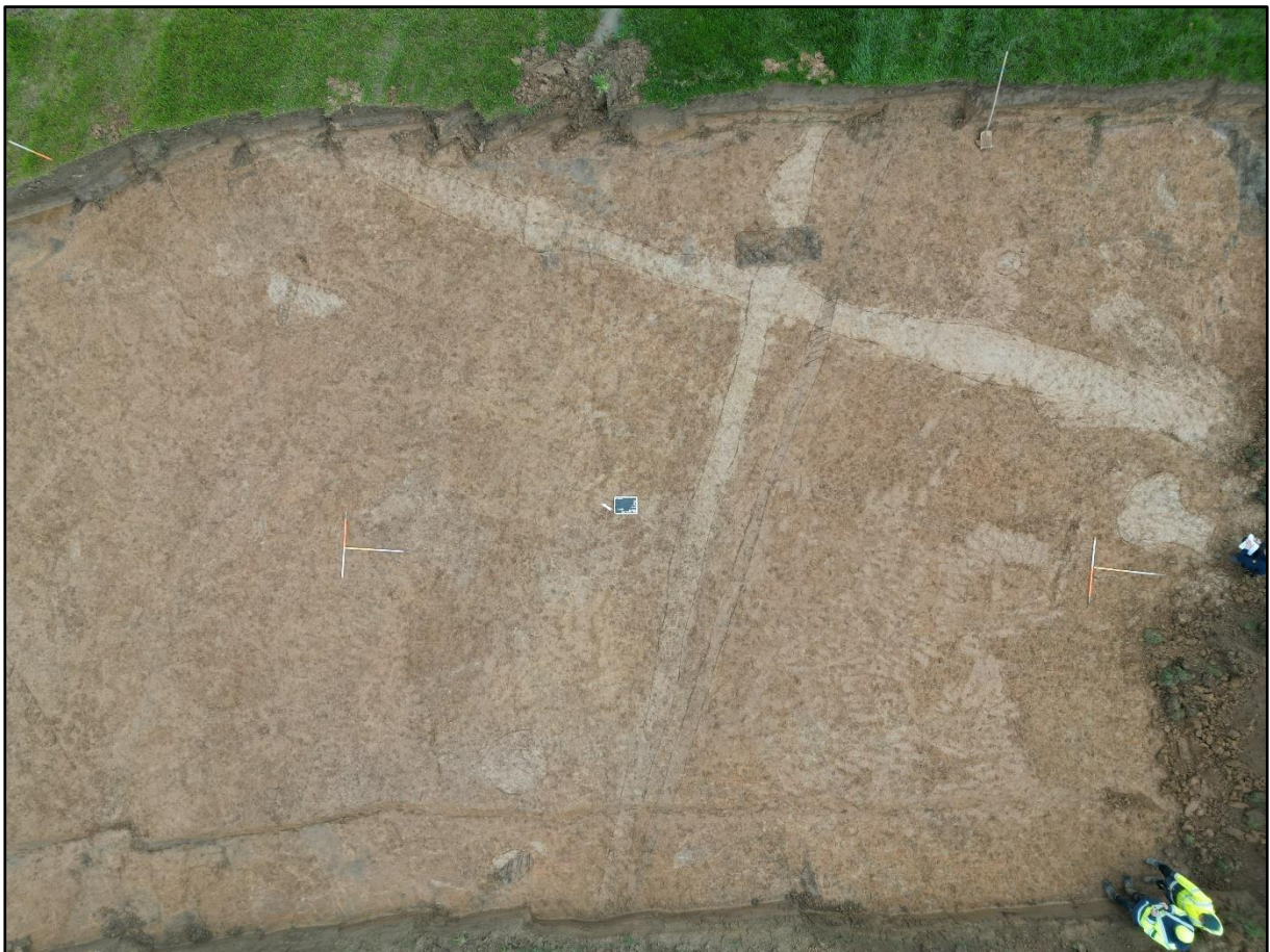
Figuur 21: Drone-opname van Zone 4C tijdens de aanleg (ABO nv 2023)
