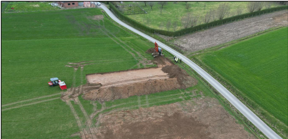
Figuur 13: Drone-opname van Zone 4A tijdens de aanleg (ABO nv 2023)
