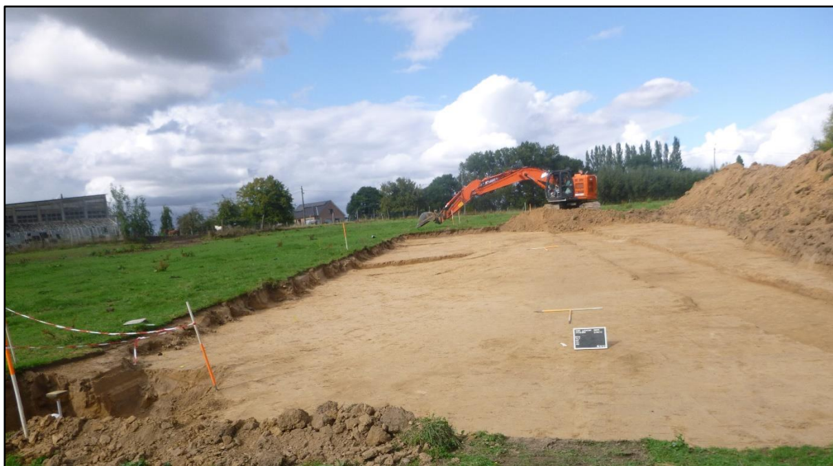
Figuur 11: Algemeen sfeerbeeld tijdens het aanleggen van het vlak in Zone 6 (ABO nv 2022)
