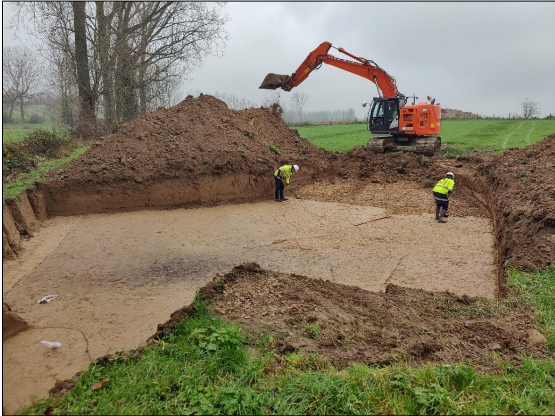
Figuur 9: Sfeerbeeld aanleg vlak ter hoogte van S7.23 (ABO nv 2022)
