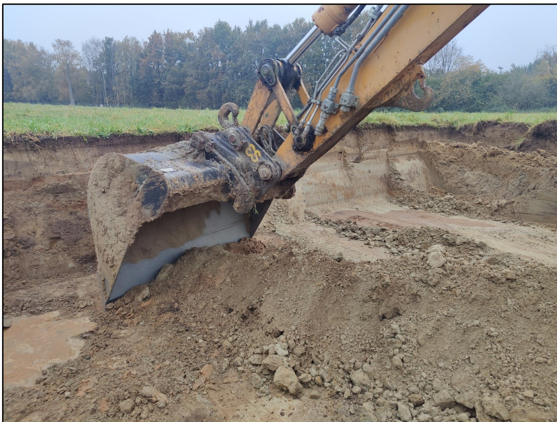
Figuur 9: Het verwijderen van het ophogingspakket (ABO nv 2021)
