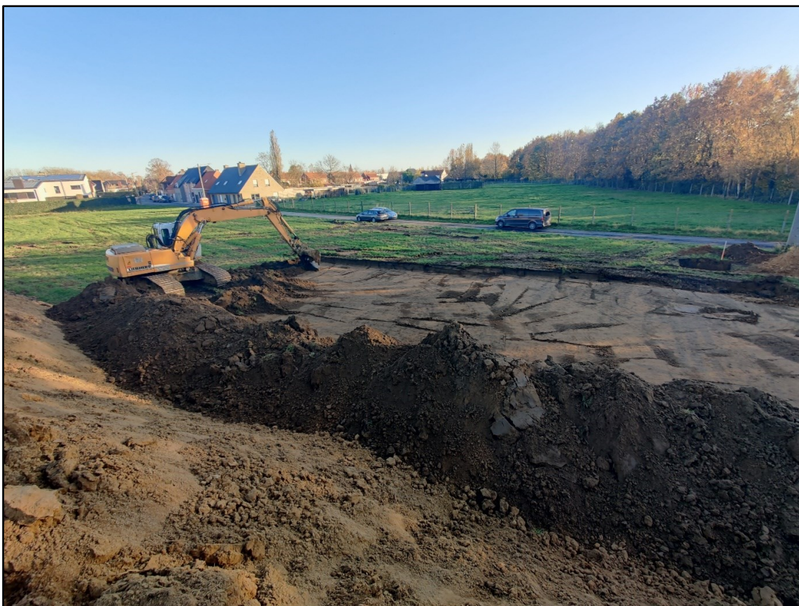
Figuur 8: Het verwijderen van het ophogingspakket (ABO nv 2021)
