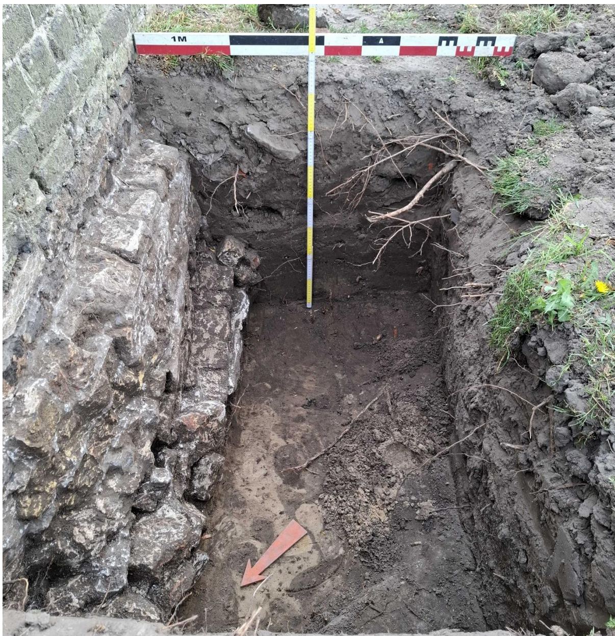
Figuur 69: Zicht vanuit het noordwesten op WP6 en P7 en P8 waarbij de verschillende oriëntaties zichtbaar zijn tussen fundering S19 en fundering S20.
