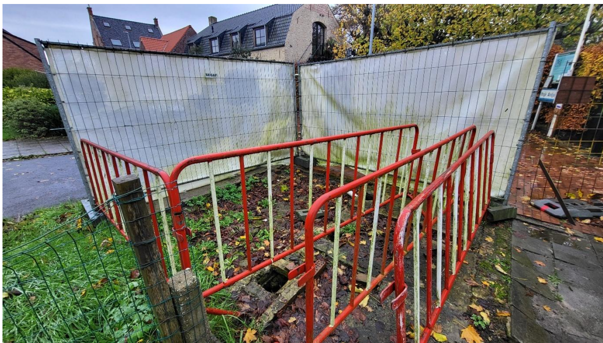
Figuur 2: Huidige toestand van het voormalige toiletgebouw (bron: initiatiefnemer).
