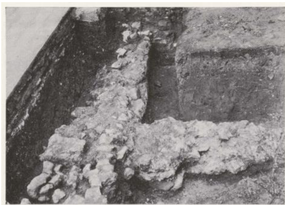
Figuur 31: Fundering van de afgebroken zuidelijke zijbeuk zoals aangetroffen tijdens de opgravingen (©Bussels, M. & Lux, G. V. 1970; Afb. 20, p. 202)
