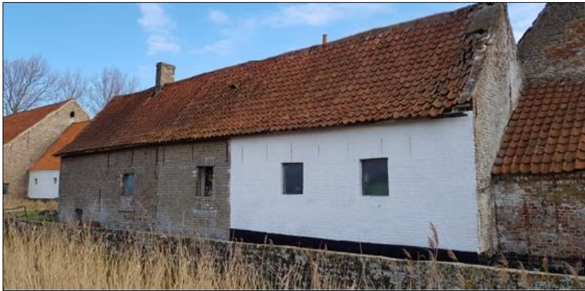
Figuur 6. Westgevel bijgebouw (Bron: Anta Architecten bv).
