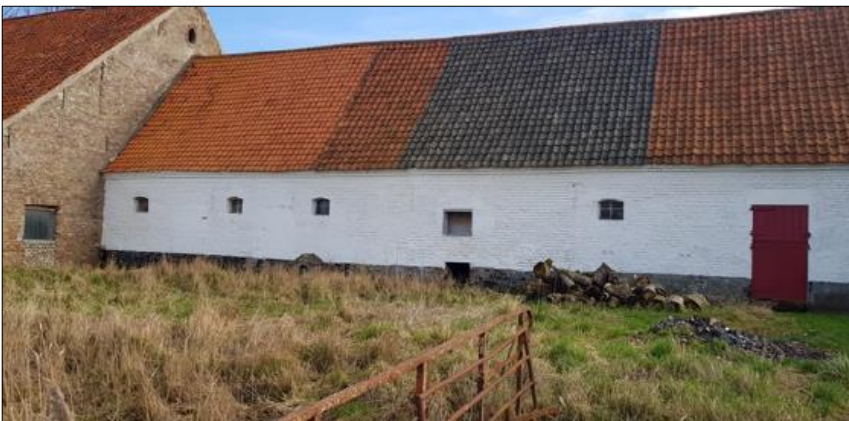
Figuur 5. Westgevel hoofdgebouw (Bron: Anta Architecten bv).
