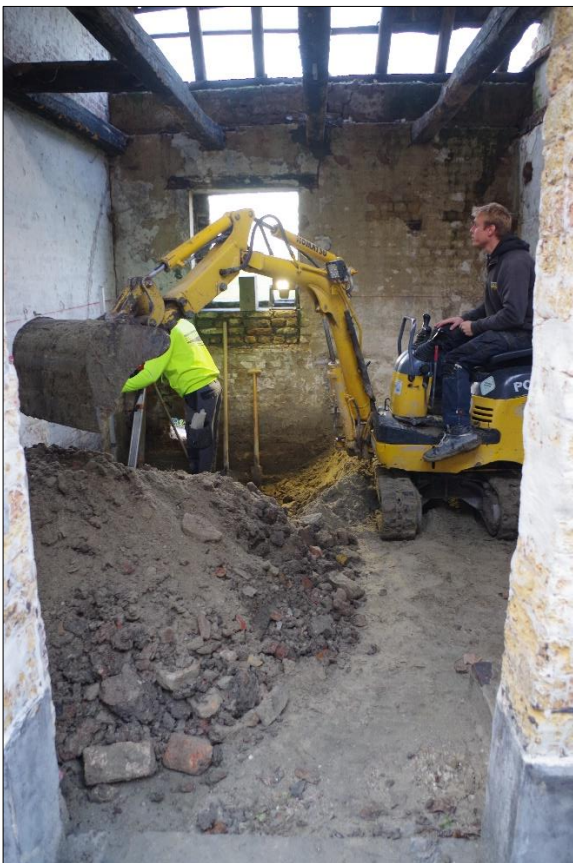
Figuur 17. Aanleg zuidelijk segment funderingssleuf in ruimte E (sfeerfoto).
