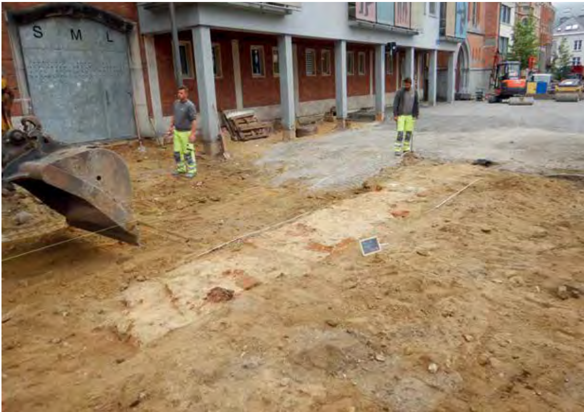
| Figuur 63: Foto vanuit het oosten van S70 A-B en S67.
