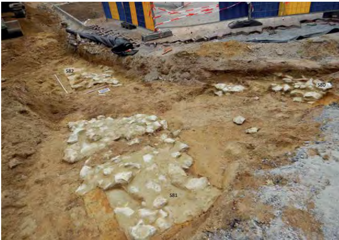
Figuur 81: Zicht vanuit het zuidwesten op funderingen S80, S81 en S82 van de westelijke cluster.
