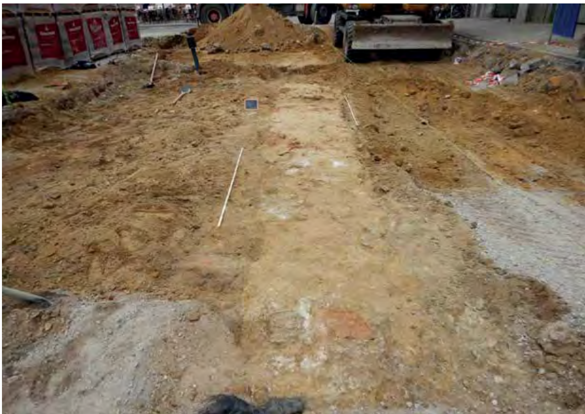
Figuur 62: Foto vanuit het noordwesten op fundering S67 (overwegend kalkzandsteen) en S70 (overwegend ijzerzandsteen, achteraan op de foto) van de zuidelijke poorthelft.
