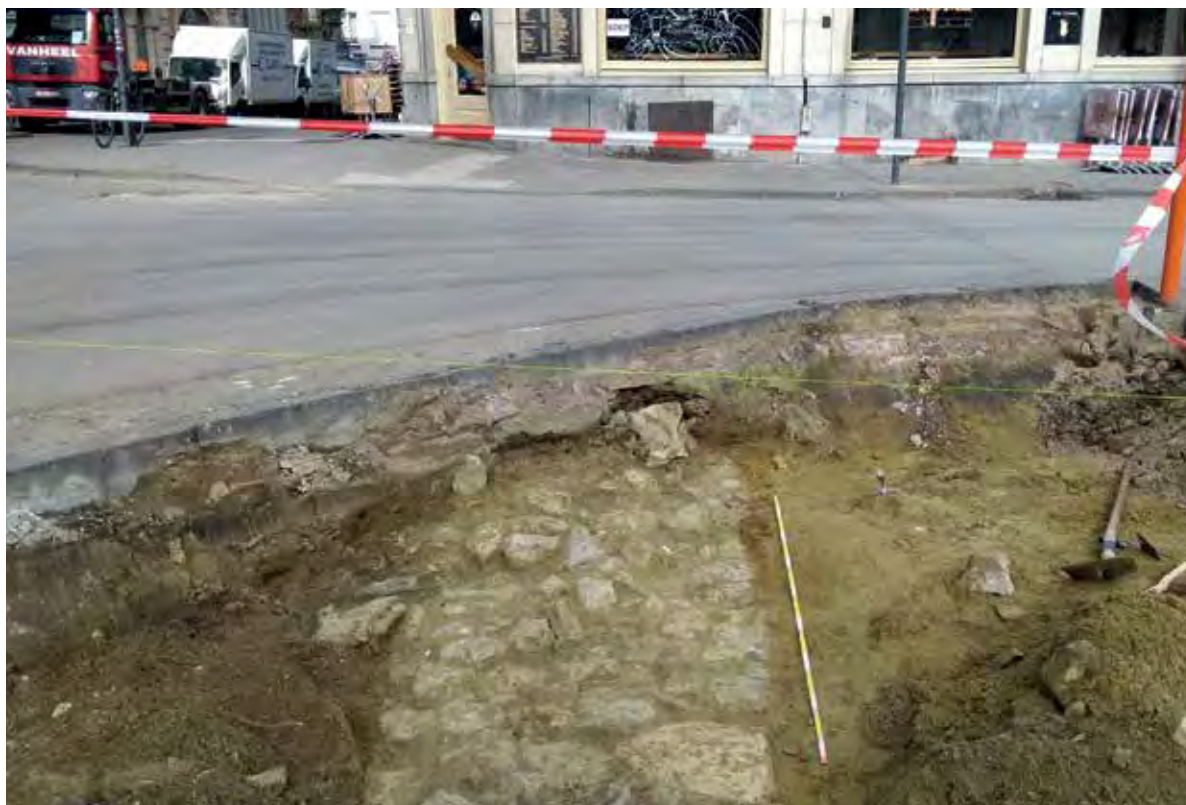
Figuur 6: Aangetroffen natuurstenen fundering S1.
