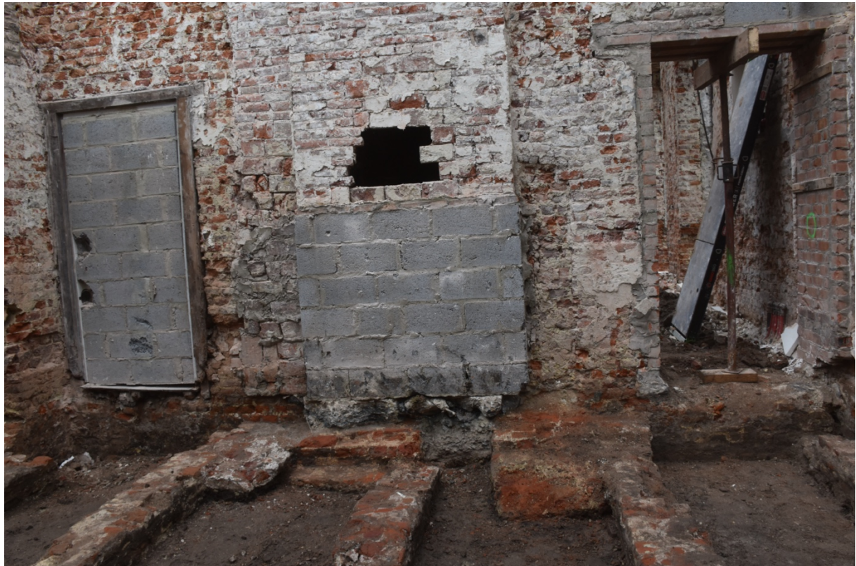
Fig. 3.33: Met betonblokken dichtgemetselde open haard op de betonvloer.
