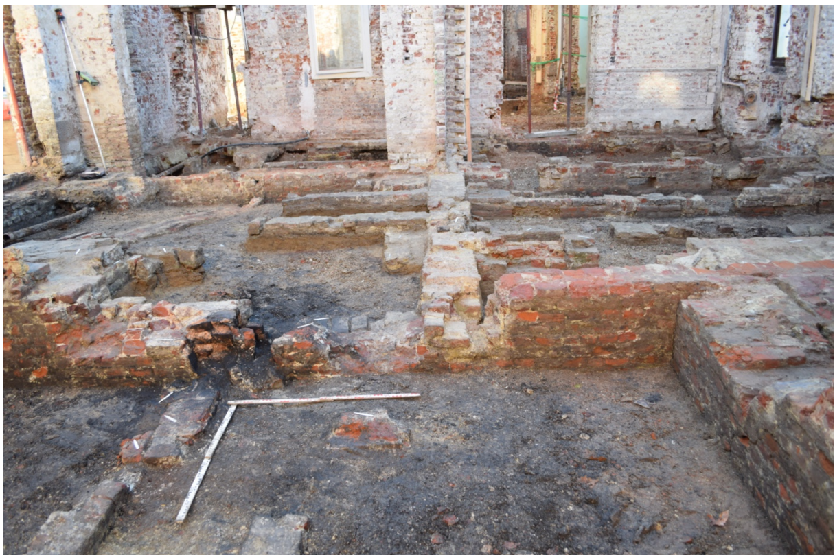
Fig. 3.49: Duidelijke zwarte roetsporen van vermoedelijk kolen op en tegen de muur en grond.
