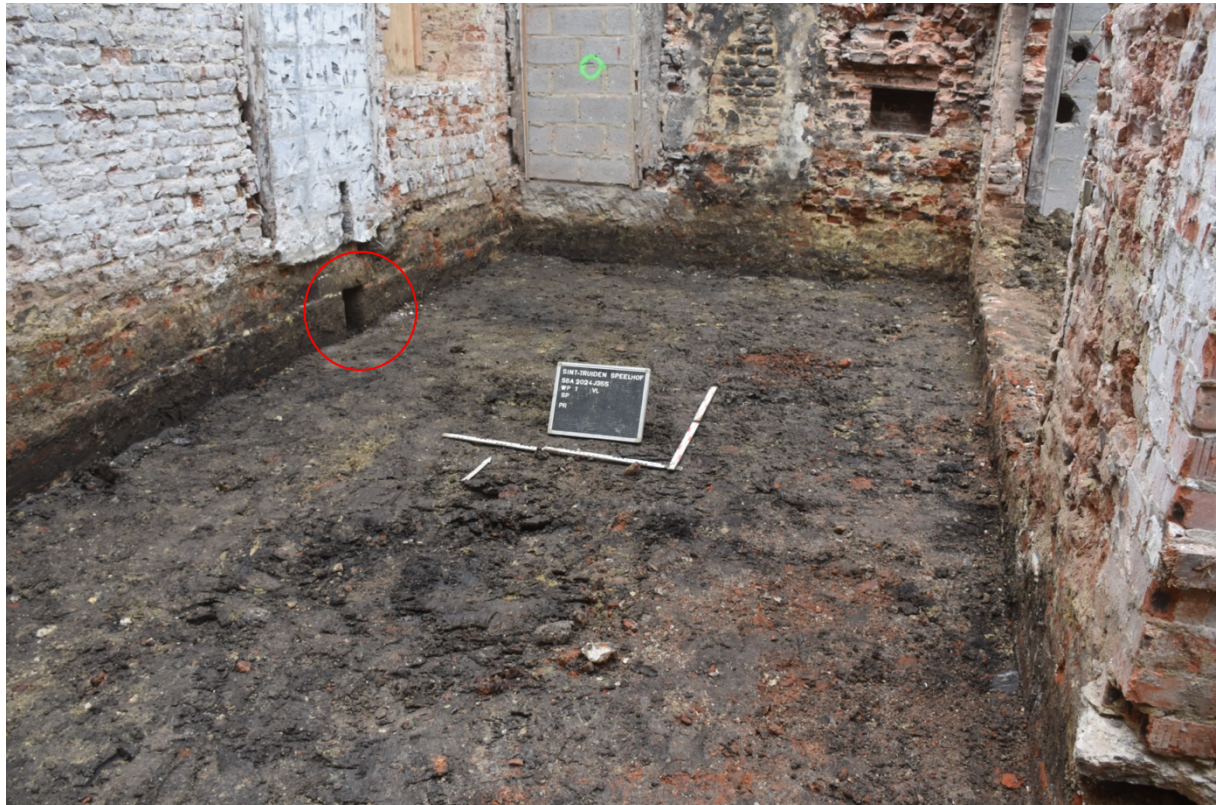
Fig. 3.37: Aanduiding van het gat in de muur, mogelijk voor (water)afvoer, met erboven de dichtgemetselde deur.
