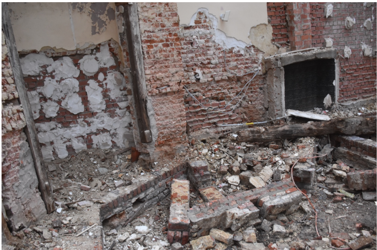
Fig. 3.39: Zicht op o.a. de recentere muur naast de open haard met een betonnen dwarsbalk.
