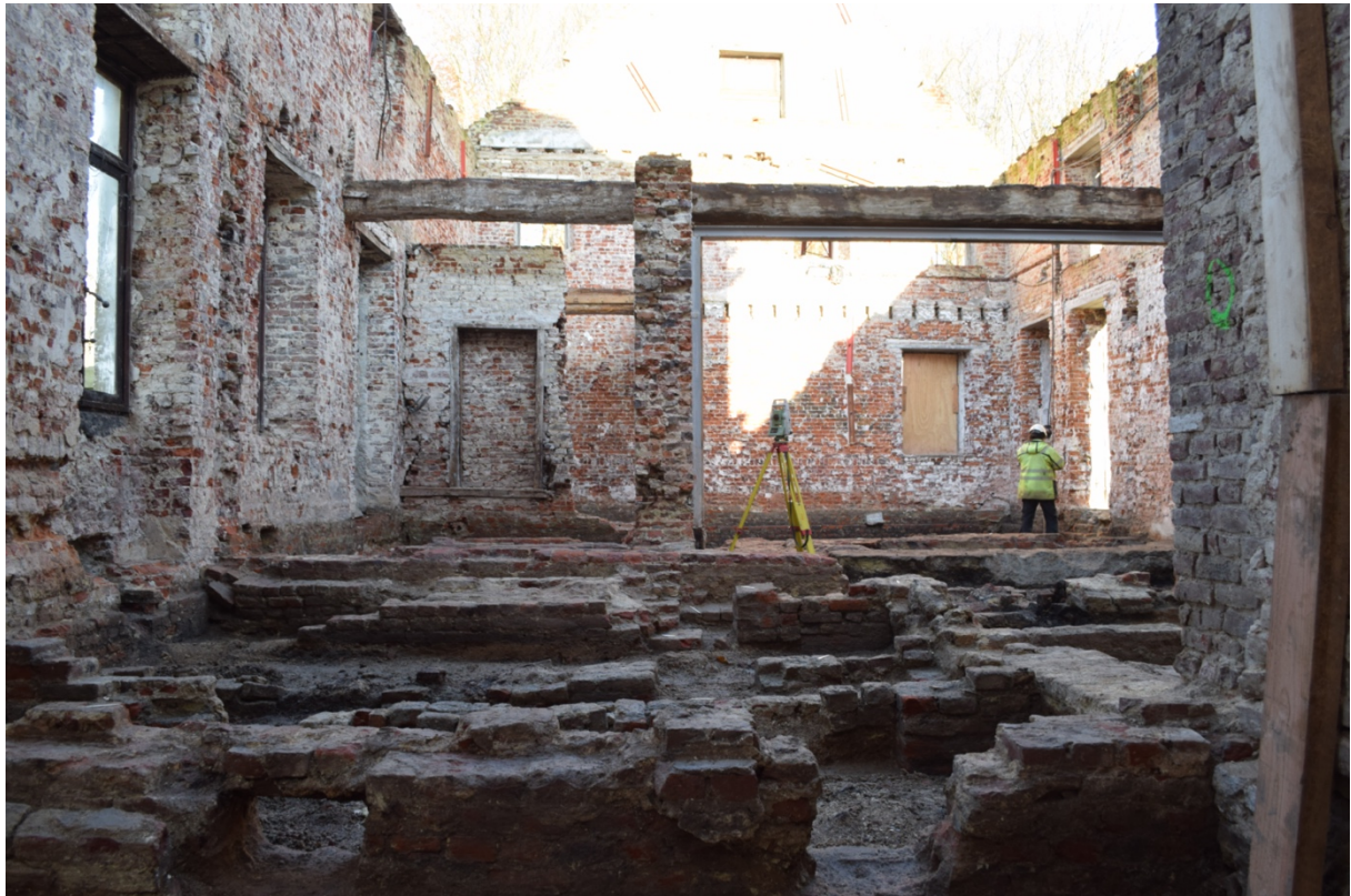
Fig. 3.48: Steunmuren voor de voormalige houten vloer met ventilatieopeningen
