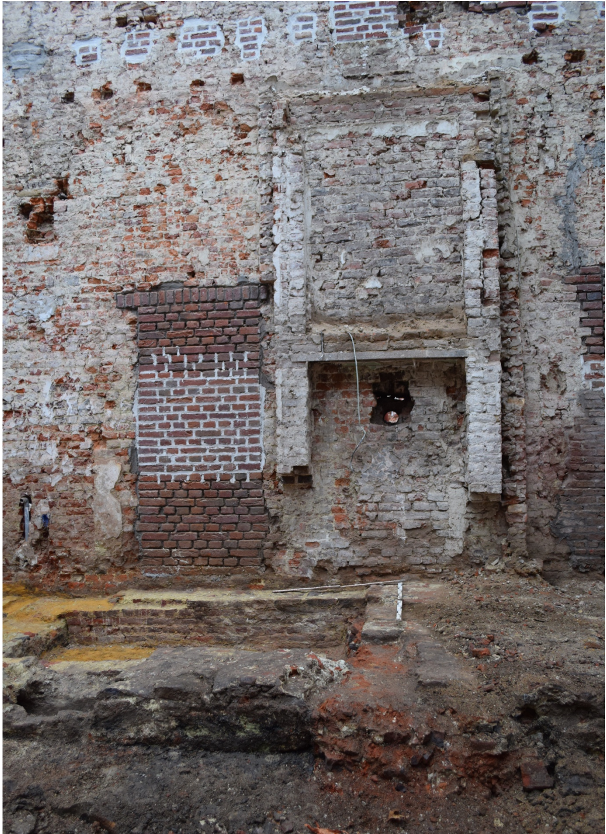
Fig. 3.45: Ouder keldertje voor nieuwere dwarsmuur en deuropening toont duidelijk de verschillende fasen. Voor de stabiliteit werden bepaalde openingen reeds dichtgemetseld.
