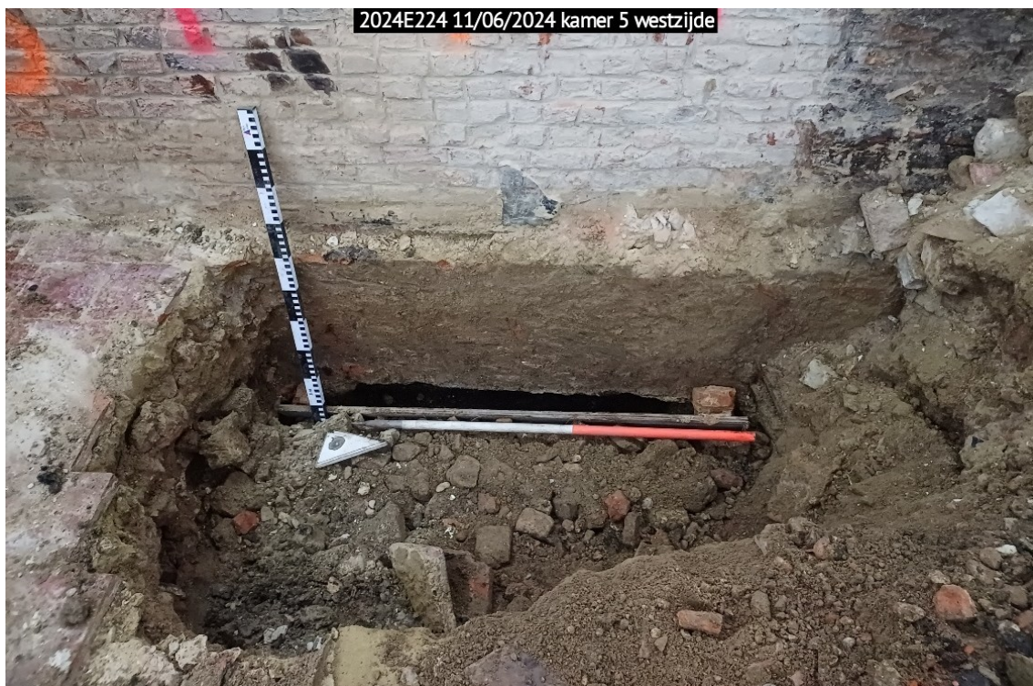
Figuur 14: Werkfoto onderschoeiingswerken binnen het gebouw
