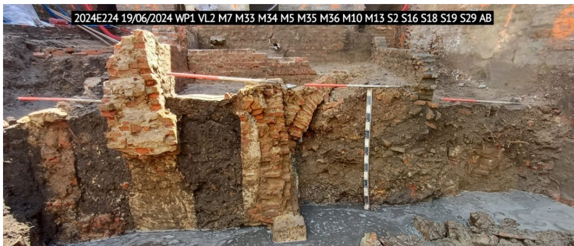
Figuur 84: Werkput 1, vlak 2, coupe door de kelder met twee keldergewelven (M10 en M36/37), waarbij de latere muur M5 op de keldervloer staat (AB)
