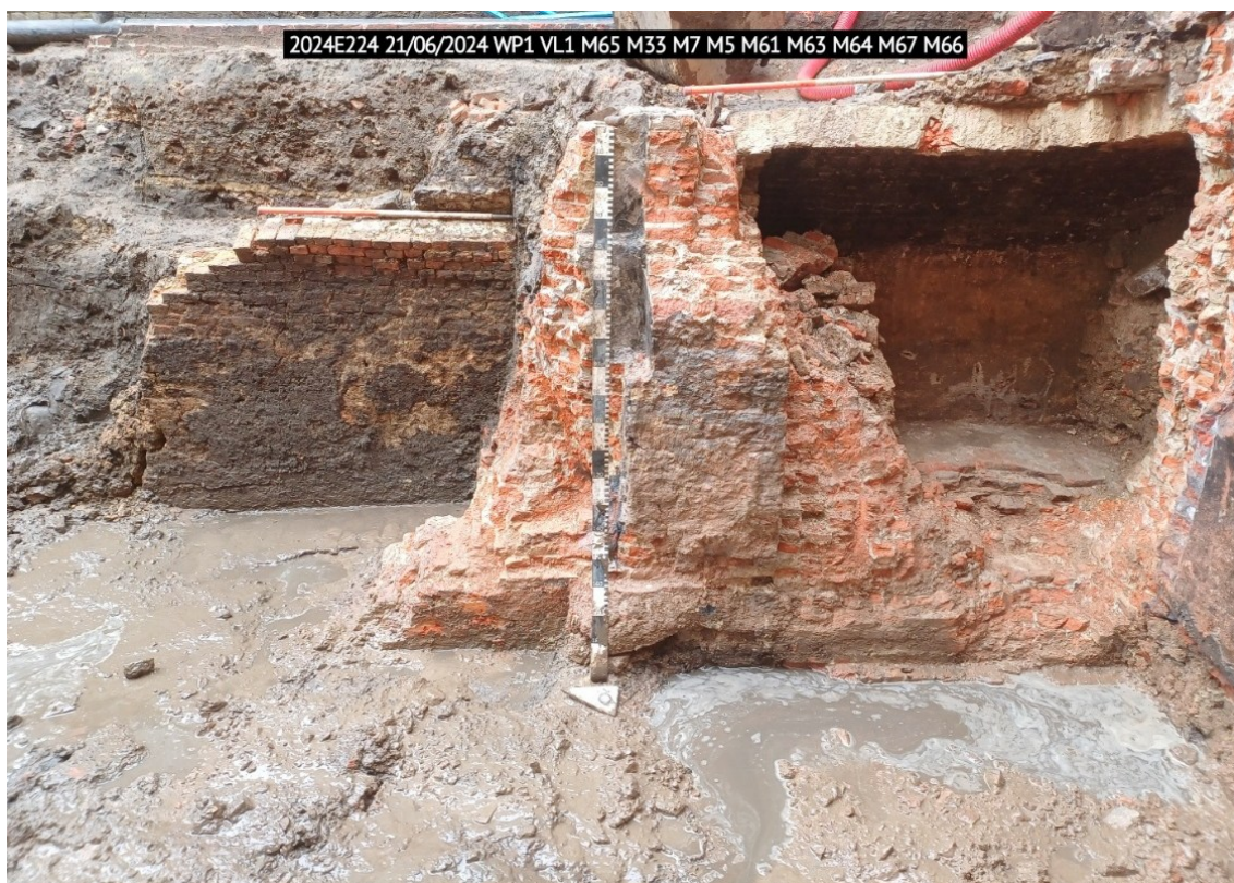
Figuur 88: Werkput 1, vlak 1, oostzijde van de kelder (M33), die deels onder het gebouw doorloopt en die aan de zuidzijde vernieuwd is (M67 en M64)
