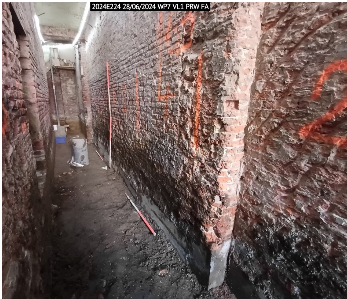
Figuur 60: Werkput 7, vlak 1, profiel west (FA) met aan de rechterzijde een verspringing in de scheidingsmuur (M49), waarbij de muur die zich zal verdergezet hebben in oostelijke richting vermoedelijk is weggekap
