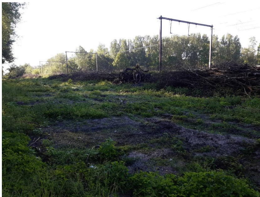
Figuur 6: Foto van de treinsporen vanaf het meest westelijke einde van werkput 2. Om veiligheidsredenen moest de kraan voldoende afstand bewaren tot de hoogspanning.
