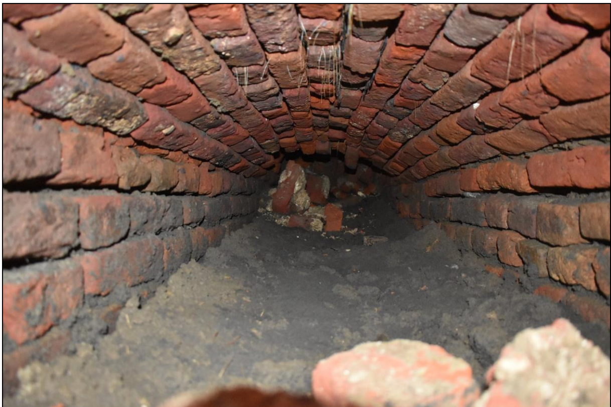
Afb. 56: Zicht in het overwelfde kanaal van S61.
