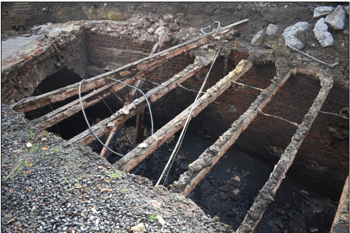
Afb. 50: De bekisting van de Nieuwe Demer na het wegbreken van het betondek en de bakstenen welfsels. Duidelijk zichtbaar zijn de stalen balken, met op de achtergrond de zuidelijke kademuur en links de brug. Het rechterdeel van de kademuur komt overeen met S1.
