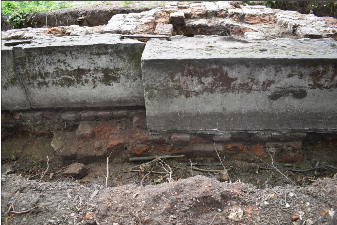
Afb. 43: Natuurstenen blokken van de bekleding langs de buitenkant van de noordmuur. De rand van de bakstenen fundering waarop de blokken geplaatst zijn is zichtbaar langs de onderkant. Ook zijn er in het midden en links bovenaan nog twee ijzeren klemmen zichtbaar om de blokken bij elkaar te houden.
