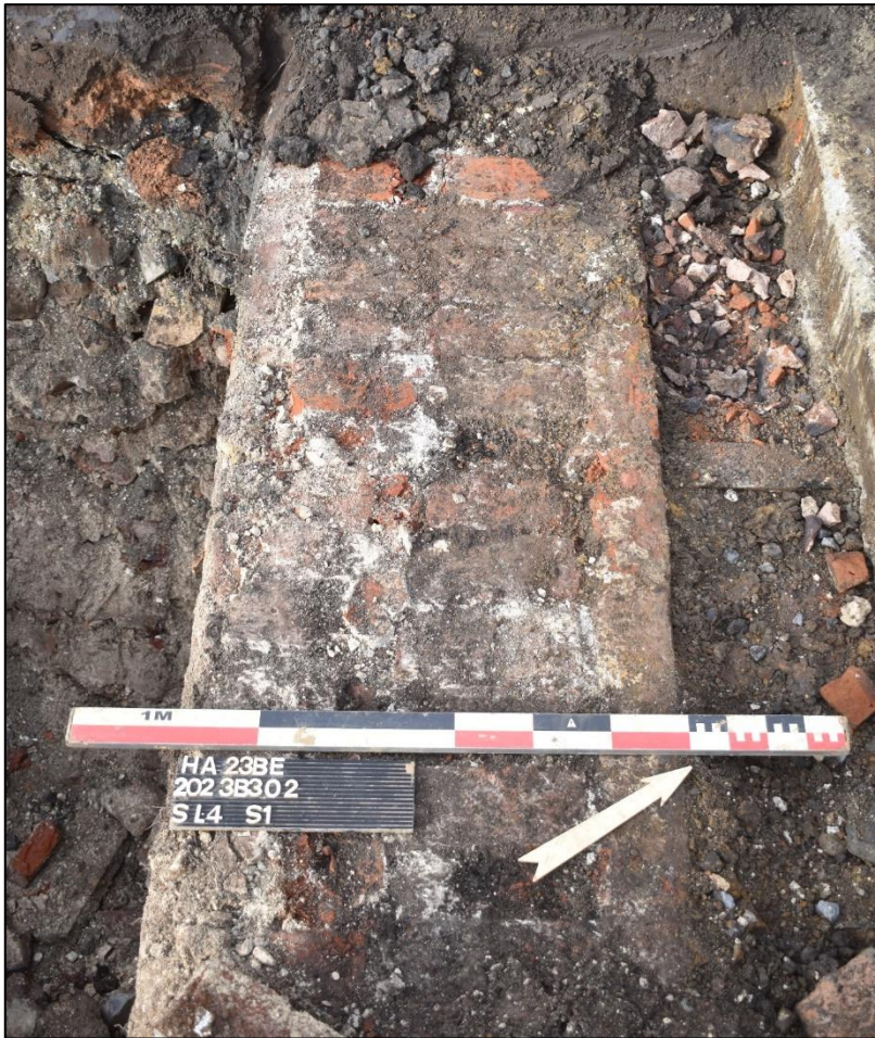
Afb. 27: Bovenaanzicht van de bakstenen muur S1. Rechts, tussen de muur en de betonnen bekisting, is de aanzet van een stalen H-profiel zichtbaar dat deel uitmaakt van de overkapping van de Nieuwe Demer.
