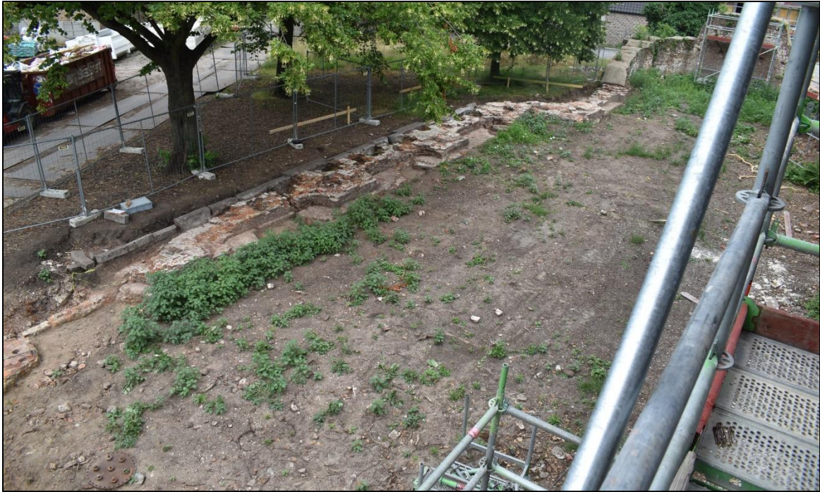
Afb. 46: Overzichtsfoto van de noordmuur waarin de nissen aan de binnenkant van de muur zichtbaar zijn.
