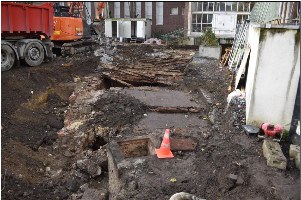
Afb. 52: Overzichtsfoto met in het midden het wegdek van de brug en op de achtergrond de opengebroken Nieuwe Demer. Op de voorgrond een moderne inspectieput die behoort tot de betonnen overkapping van de Nieuwe Demer aan de oostzijde van de brug.
