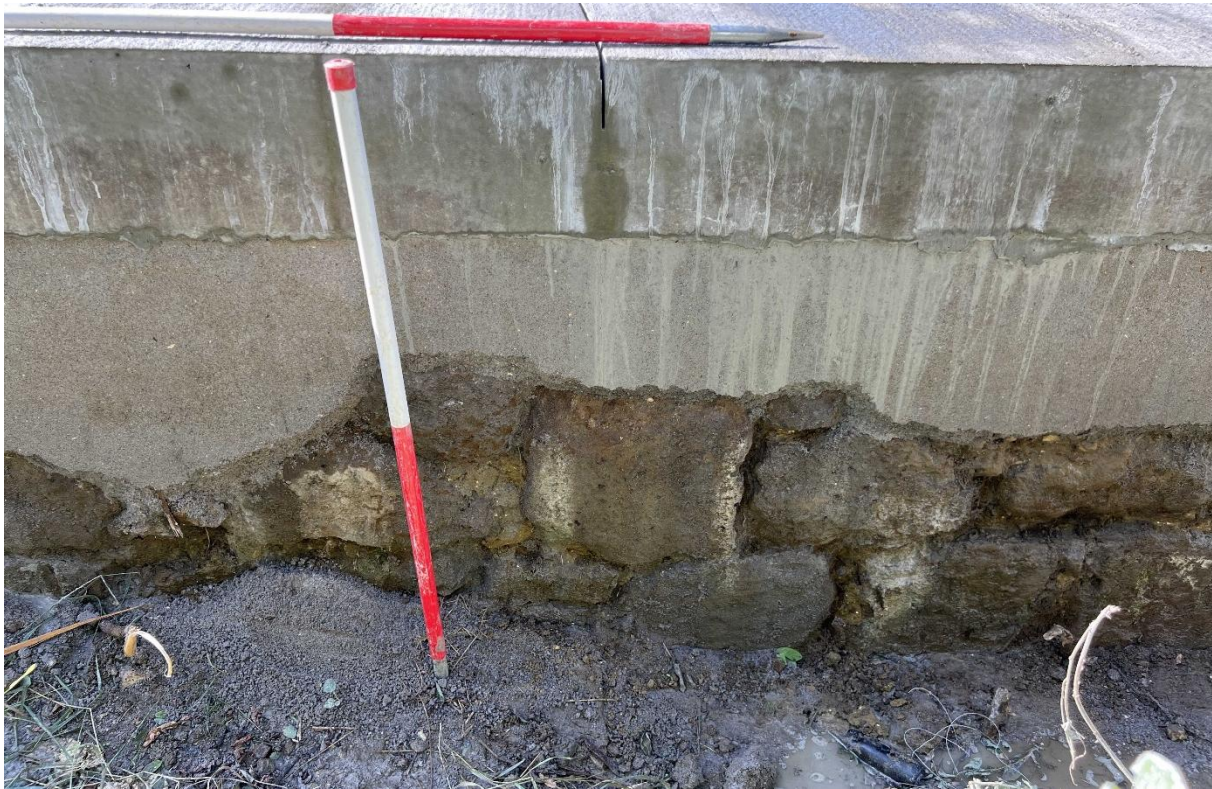
Figuur 50: Zicht op ijzerzandstenen muursegment S52.
