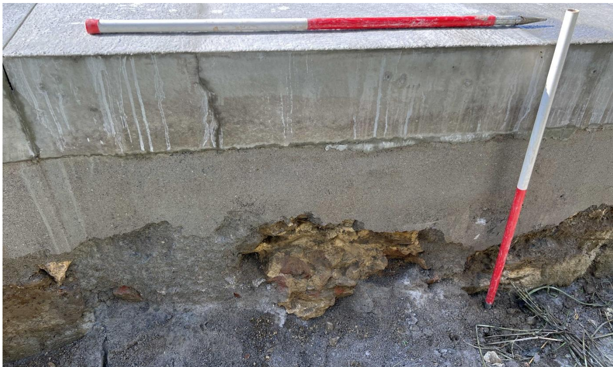
Figuur 47: Resten van een vermoedelijke herstelling in baksteen S53 en met harde gelige kalkmortel.
