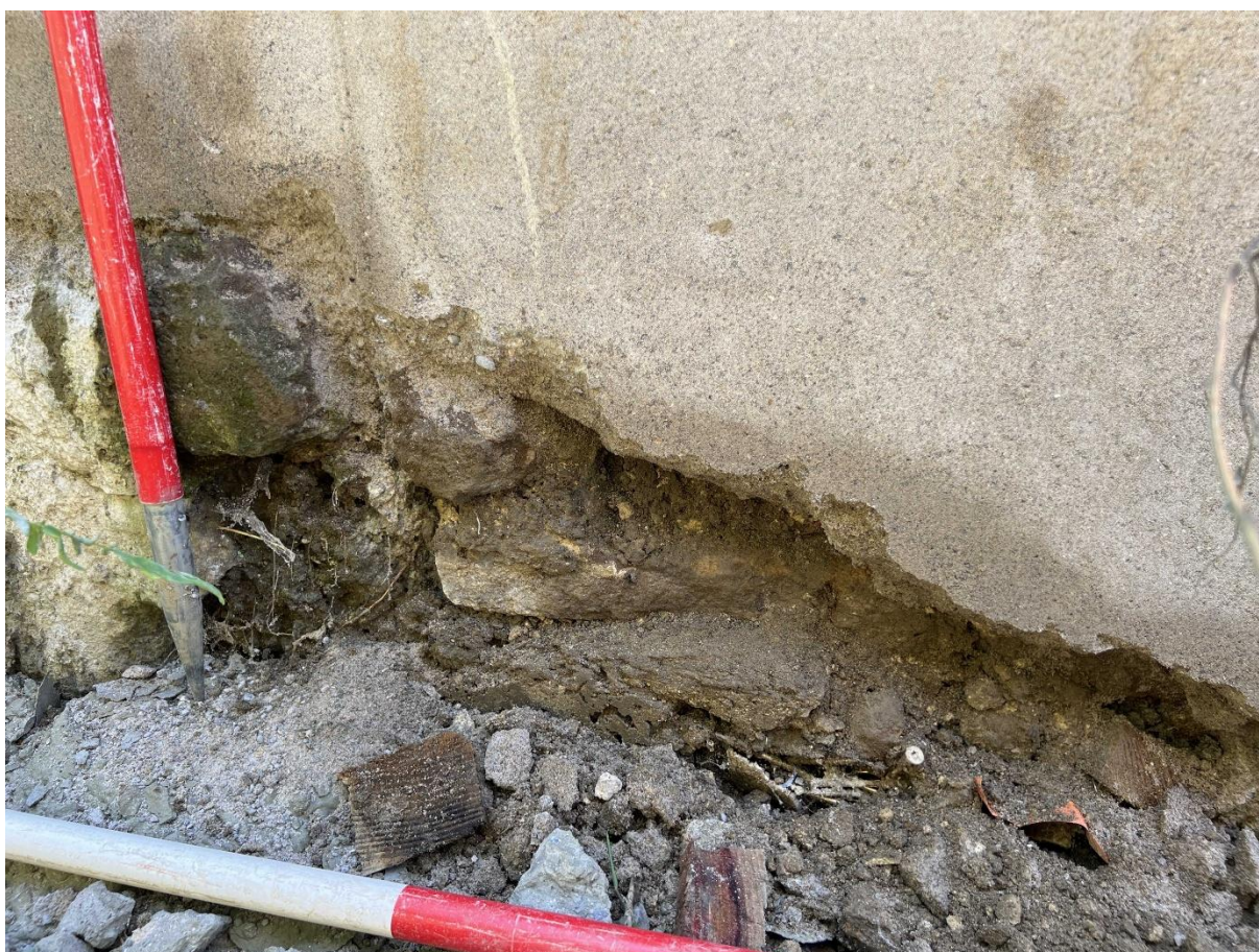
Figuur 55: Muursegment S59 met baksteen.
