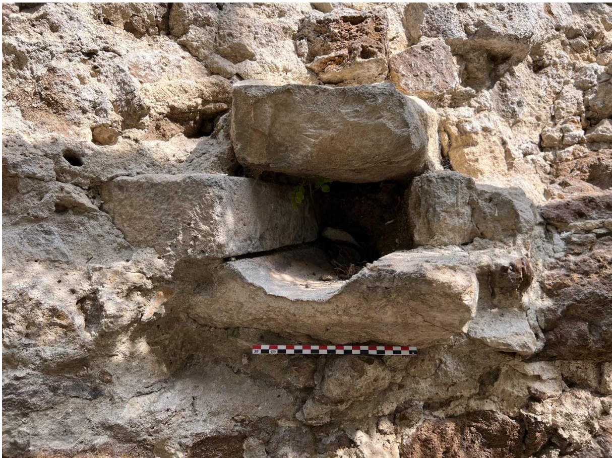
Figuur 70: Frontaal zicht op afvoergoot S46.
