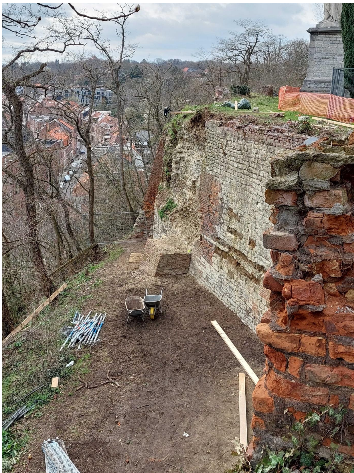
Figuur 73: Zicht op de zuidzijde van de burchtmuur met achter de kruiwagen de volledig in baksteen opgebouwde steunbeer met daar achter het restant van de vermoedelijk oudere kalkzandstenen-bakstenen steunbeer.
