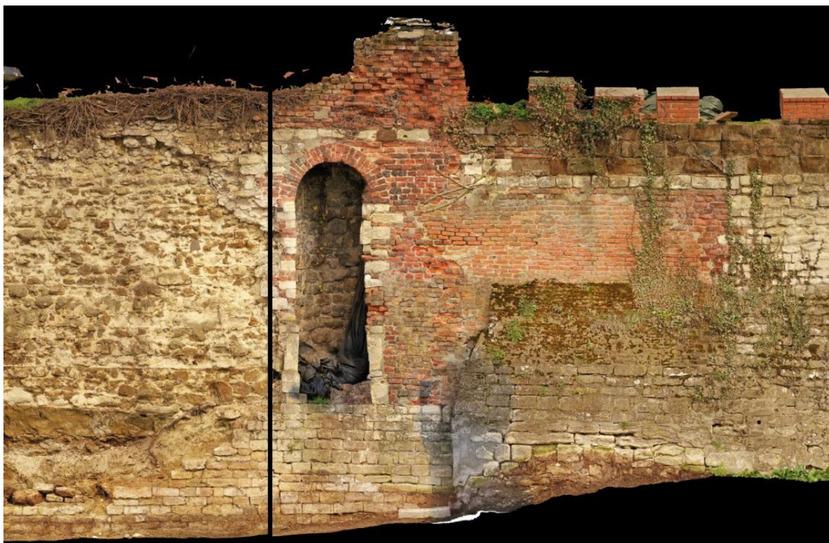
Figuur 76: Orthofoto ter hoogte van de opening in de muur na opkuis van de muur en vóór de restauratiewerken.
