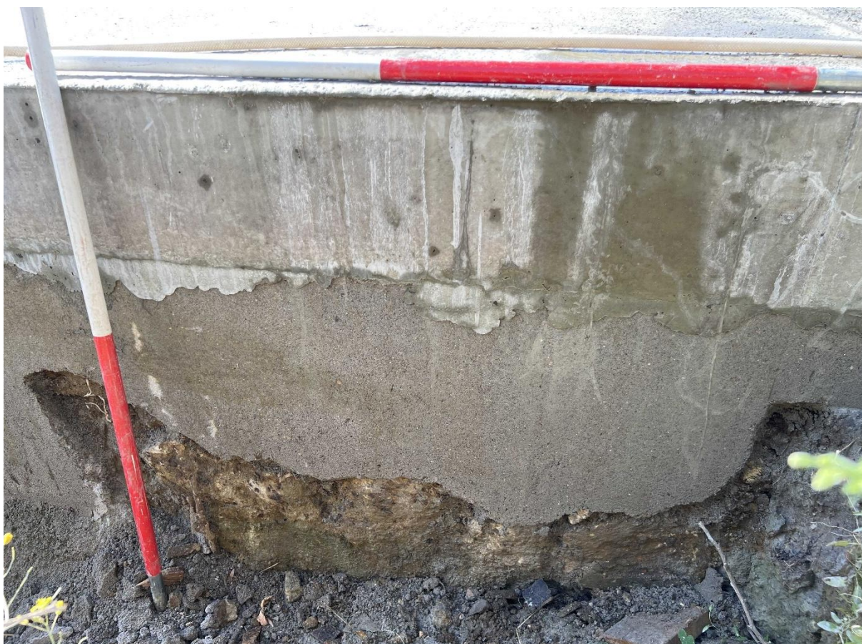
Figuur 52: Zicht op ijzerzandstenen muursegment S55.
