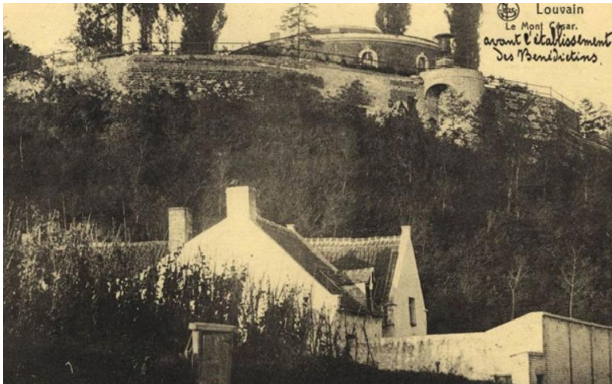
Figuur 20: Foto (Edmons Fierlants) uit de tweede helft van de 19de eeuw met zicht vanuit het zuiden op de Keizerberg en de burchtmuur waarachter nog de restanten van onderbouw van de stenen graanmolen te zien zijn. 10
