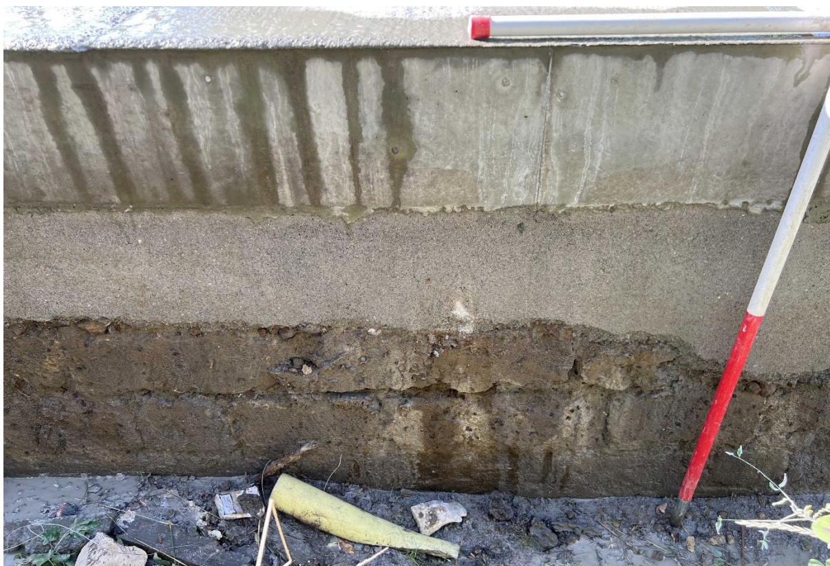
Figuur 49: Zicht op ijzerzandstenen muursegment S54.
