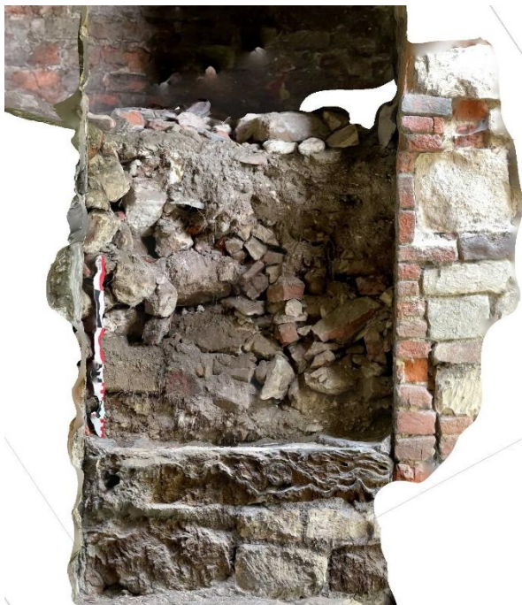
Figuur 74: Fotogrammetrische registratie van profiel 21 met de puinige vulling van de toegangstrap doorheen de burchtmuur.
