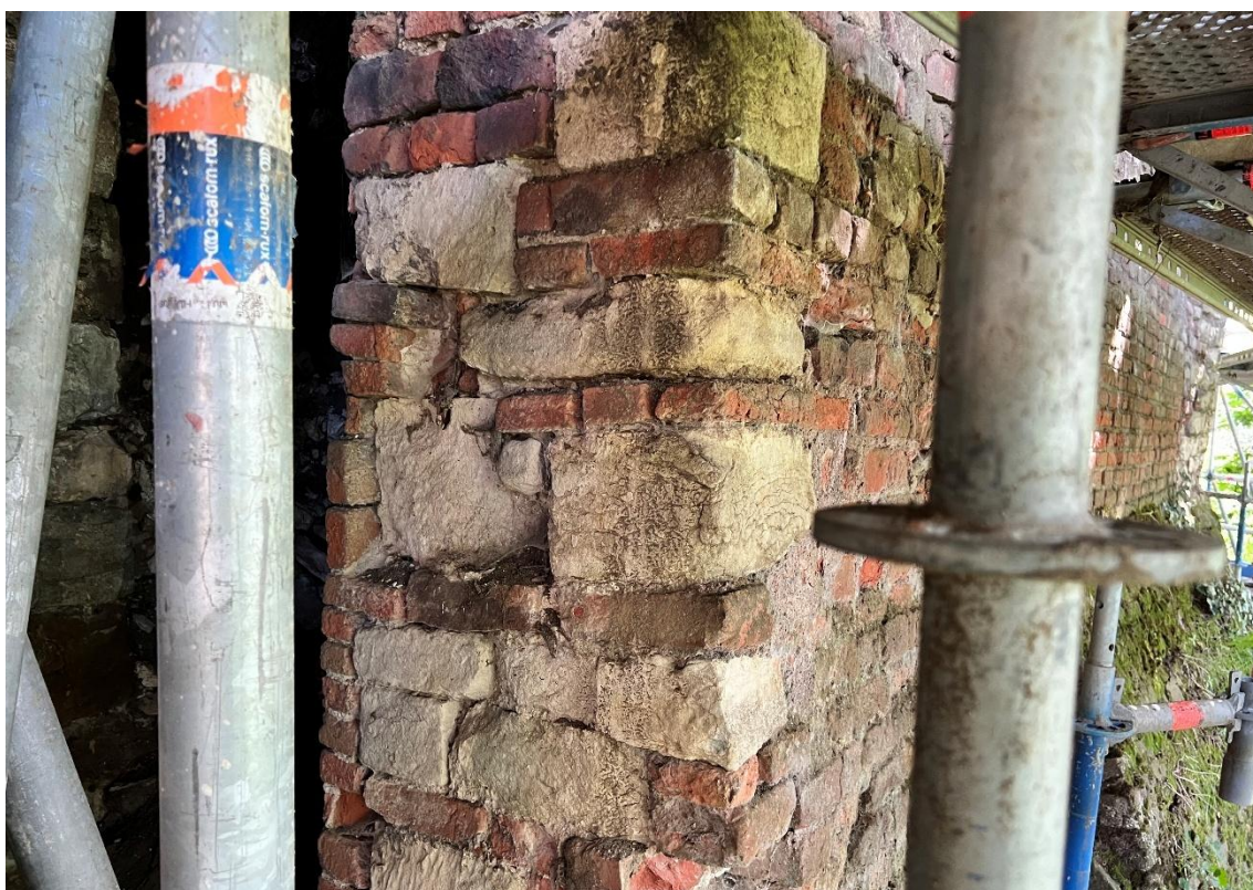
Figuur 78: Zicht op de oostelijke zijde van de ingang opgebouwd uit gerecupereerde natuursteen en baksteen.
