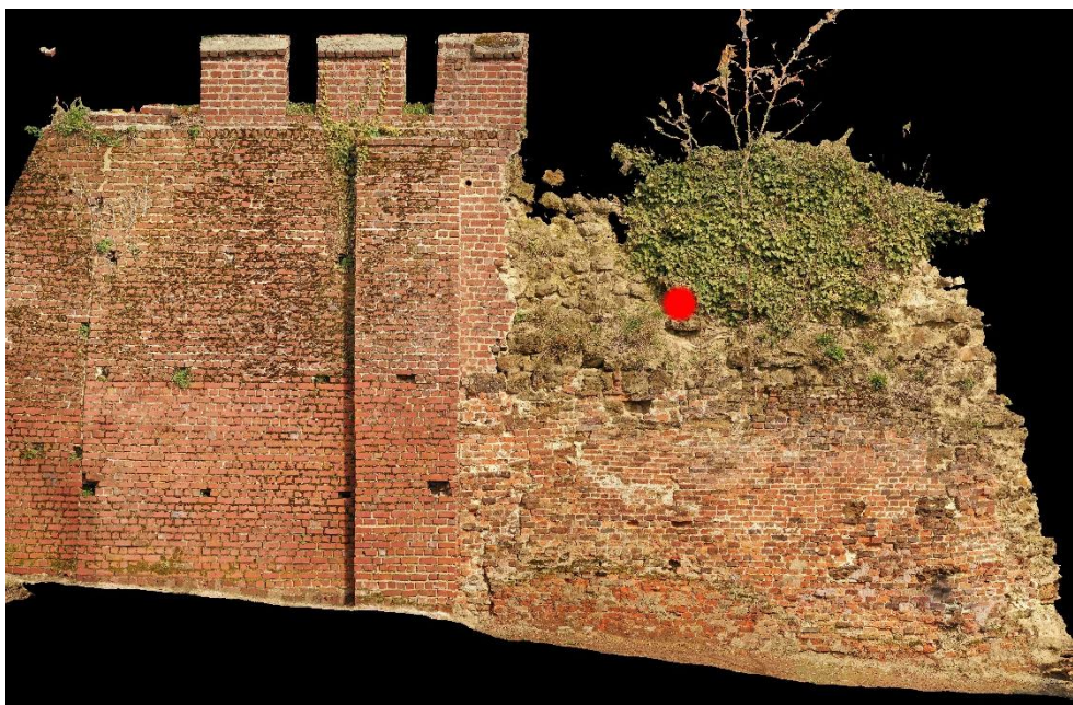
Figuur 87: Gevelaanzicht 3 met de locatie van de staalname van mortelstalen invnr. 52, 53 en 54.
