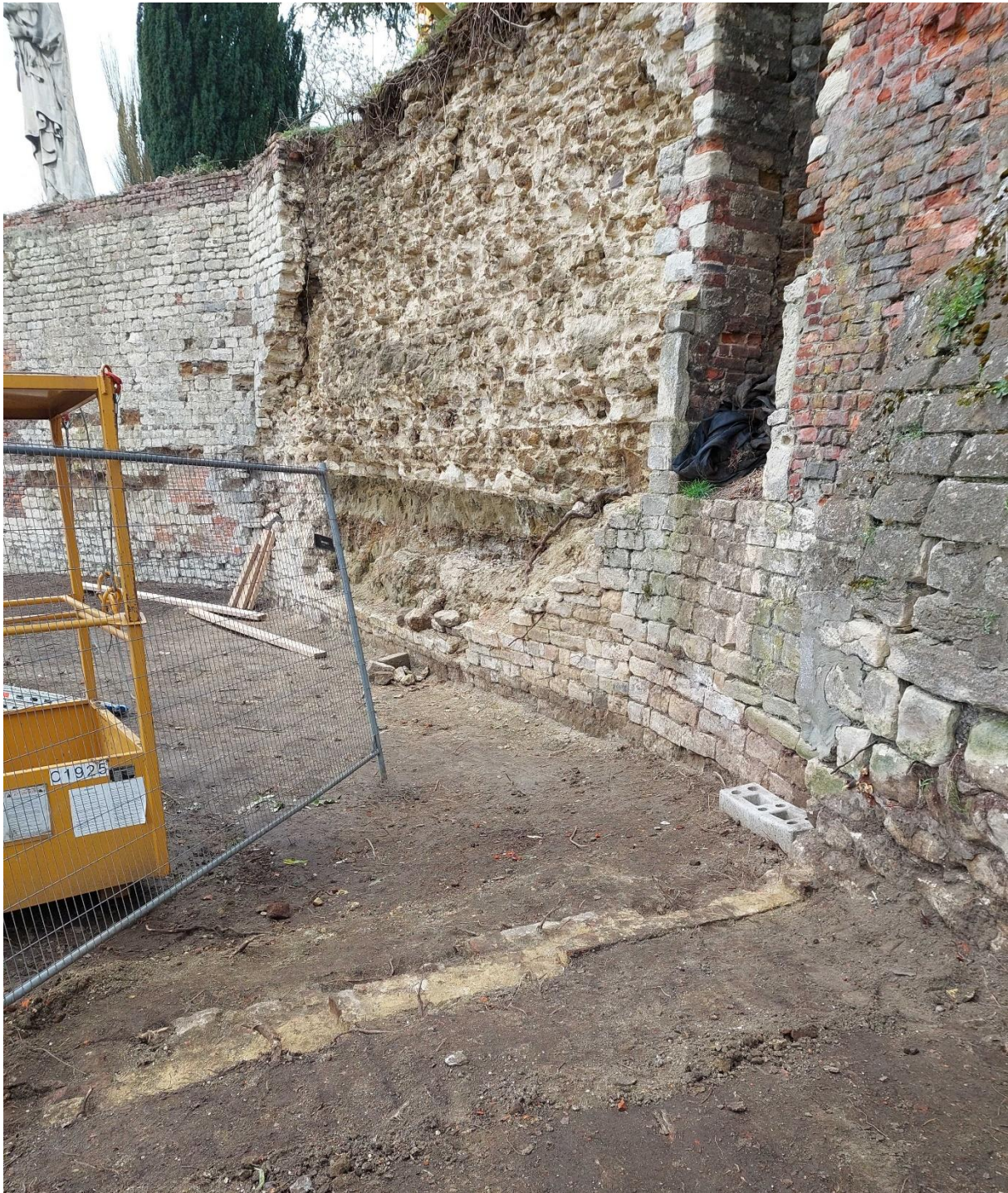
Figuur 82: Zicht vanuit het oosten op bakstenen muur S44 die tegenaan de burchtmuur werd gezet. Merk de opening naar een oorspronkelijke toegangstrap doorheen de burchtmuur op. Op deze foto is ook goed de oorspronkelijke binnenvulling in ijzerzandsteen van de burchtmuur te zien. Het parament werd hier gevormd door rechthoekig gekapte blokken (vermoedelijk Brabantse) kalkzandsteen.
