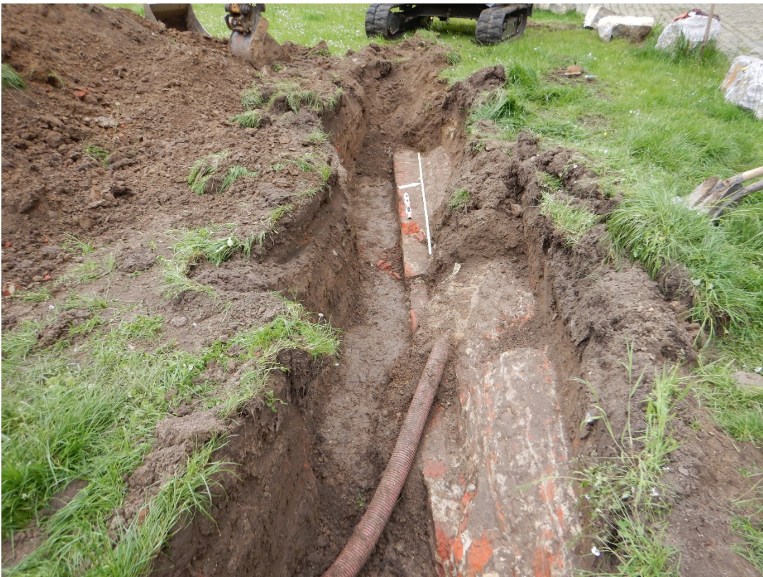
Figuur 13: de bakstenen riolering in sleuf 1.
