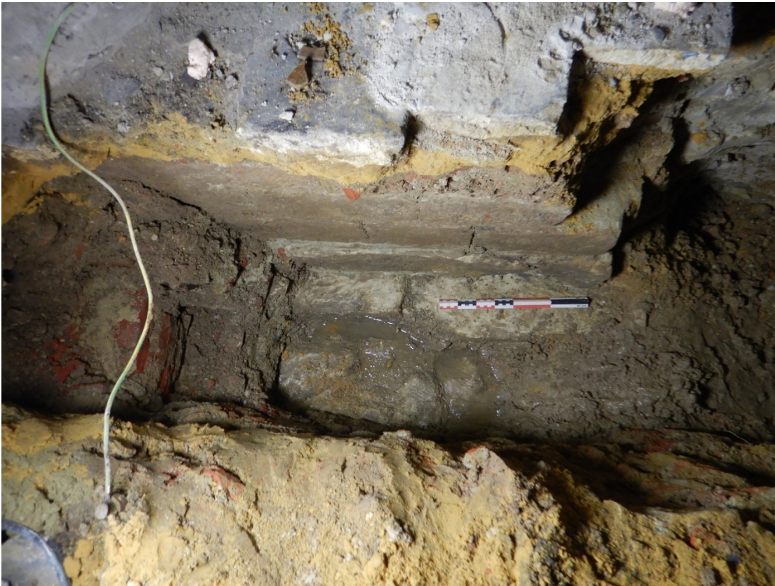
Figuur 35: sleuf 3 met in het profiel onder de vloer muur S16 met een vertanding (waar het latje op ligt) en daaronder een natuurstenen niveau (S17).
