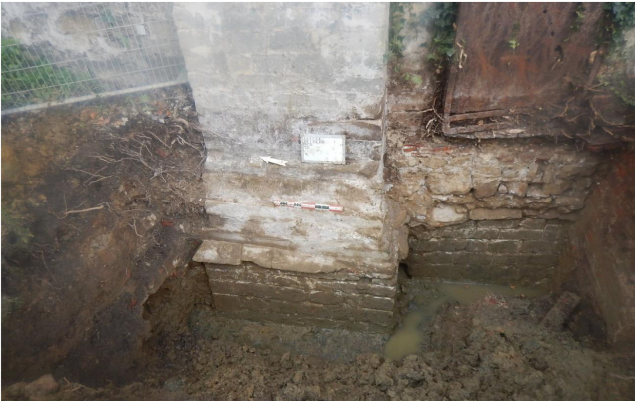
Figuur 6: werkput 4 met de steunbeer met cordon en de ophogingslagen (© Monument Vandekerckhove).
