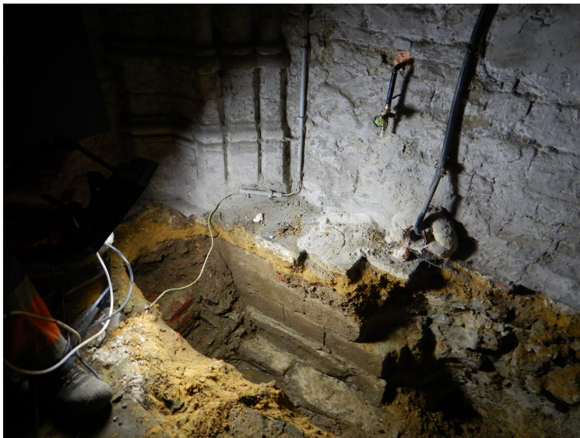
Figuur 33: Natuurstenen muur S16 in sleuf 3.
