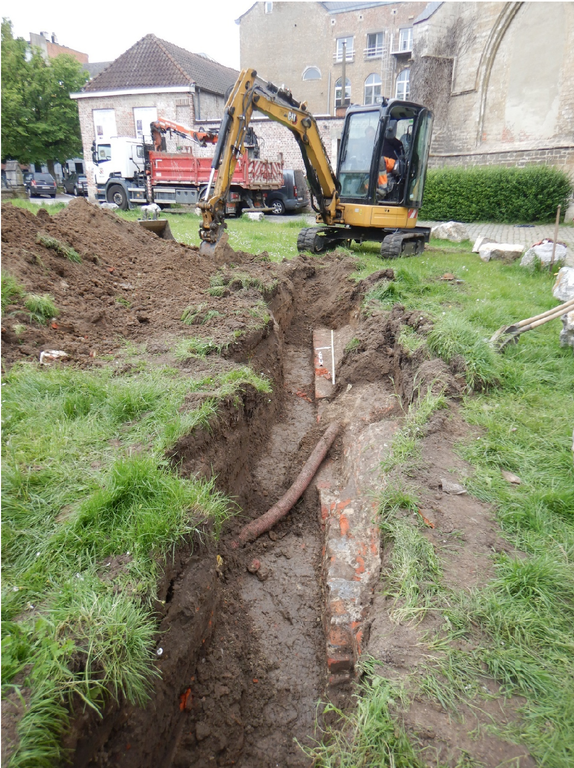
Figuur 26: Foto van sleuf 1 vanuit het oosten met de bakstenen riolering.
