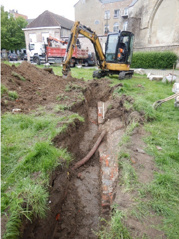
Figuur 12: sleuf 1 met de riolering aan de oostzijde.
