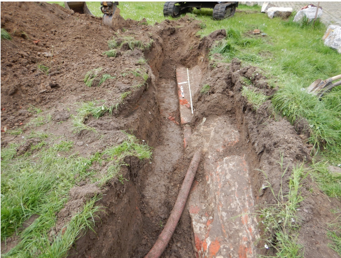
Figuur 28: Bakstenen riolering S2.
