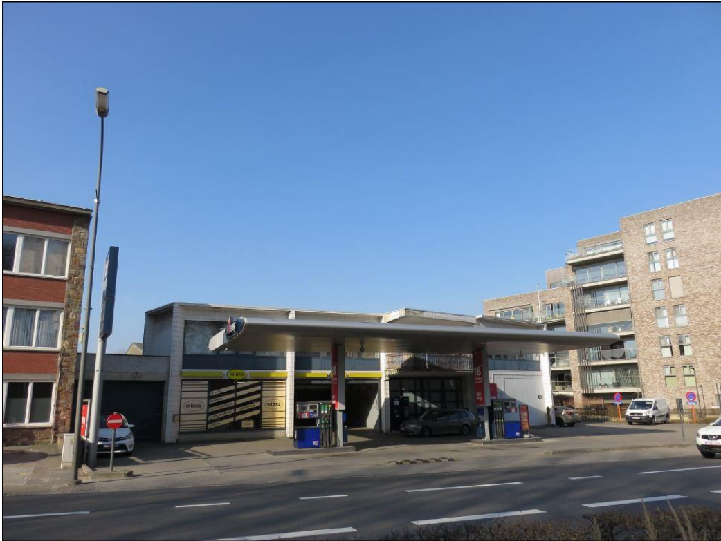
Afb. 6: Foto van de huidige toestand van het projectgebied, genomen vanaf de Elfde Novemberwal (Bron: opdrachtgever; dd onbekend; 2018B318).
