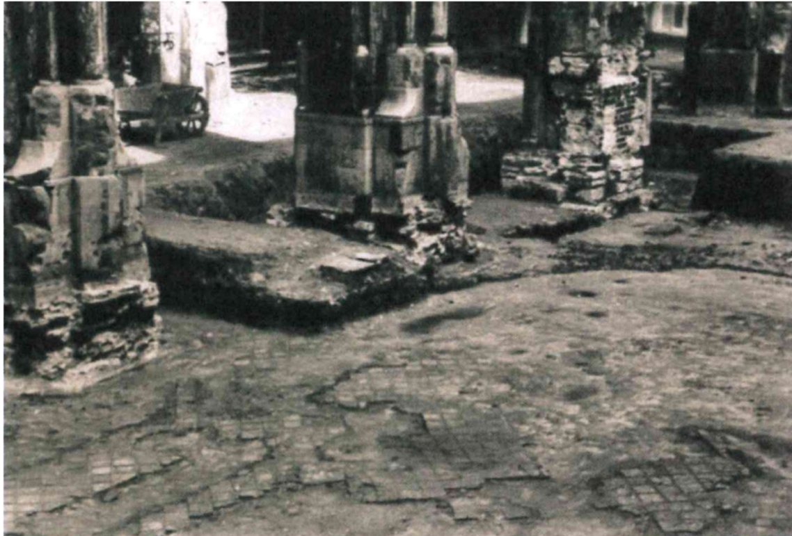
Figuur 19. Foto van de opgraving uit 1940-1941 in de St.-Pieterskerk met zicht op de tegelvloer van de Romaanse kerk. Ook op de foto zijn de bakstenen poeren van de zuilen te herkennen (bron: privécollectie R. Verstringe uit S.N., 2018, 6).
