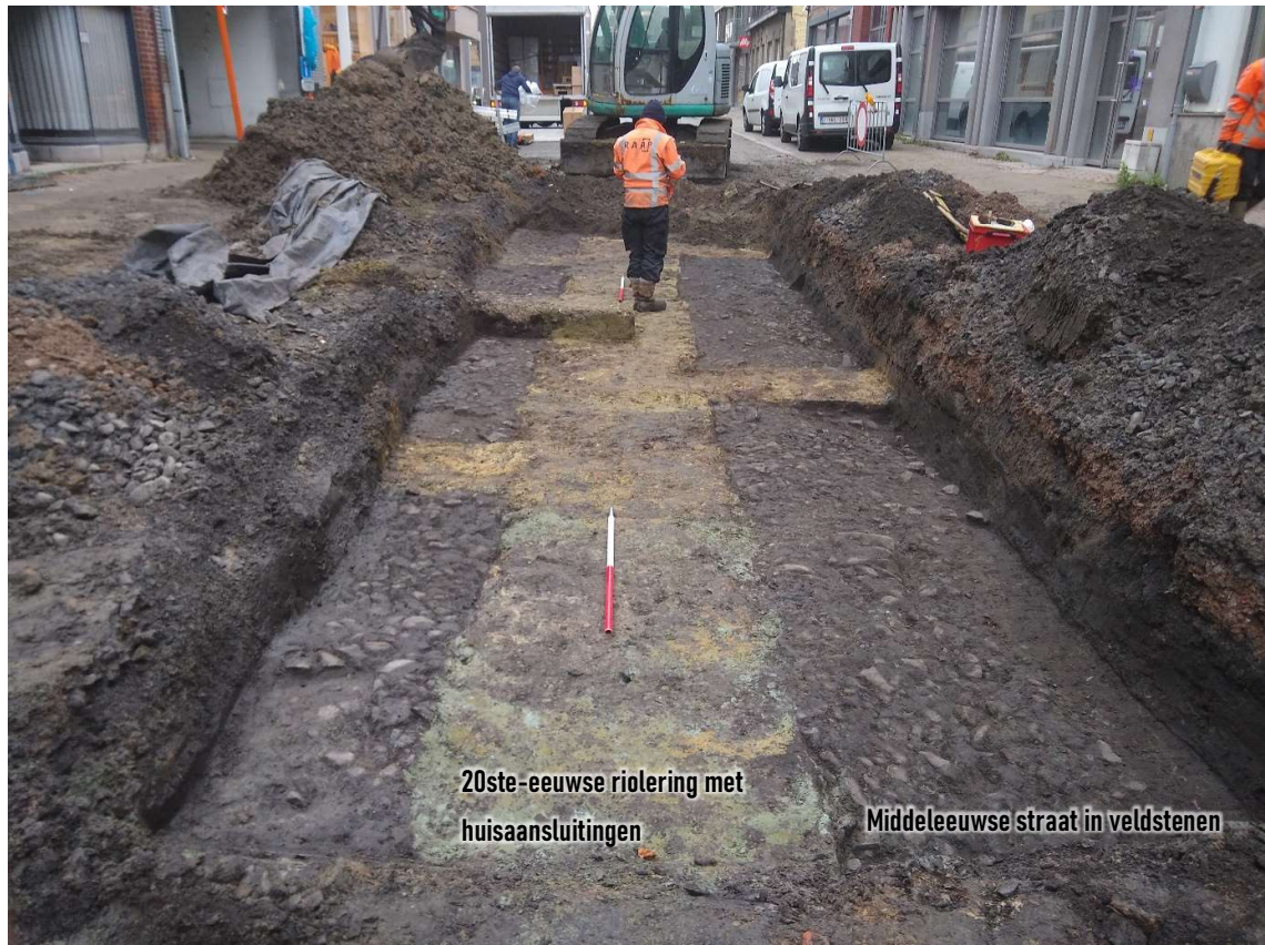
Figuur 12. Onderzoek in de Zuidstraat. Op een diepe van 30cm kwamen links en rechts van de oude riolering (grijsgroen gevlekt) straatstenen aan het licht. Deze veldstenen maken deel uit van een middeleeuwse straat.
