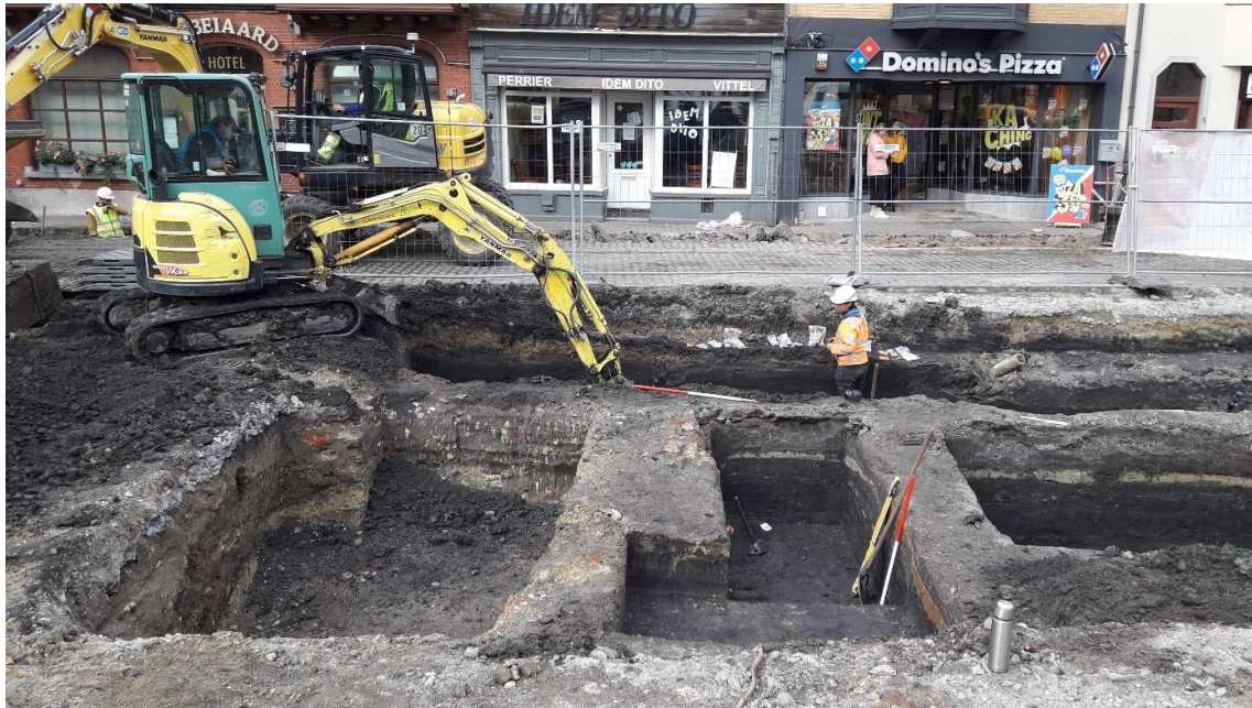
Figuur 4. Overzicht op de deelzones binnen werkput 4. In functie van het verkrijgen van inzicht in de stratigrafie werden voldoende profielbanken behouden.
