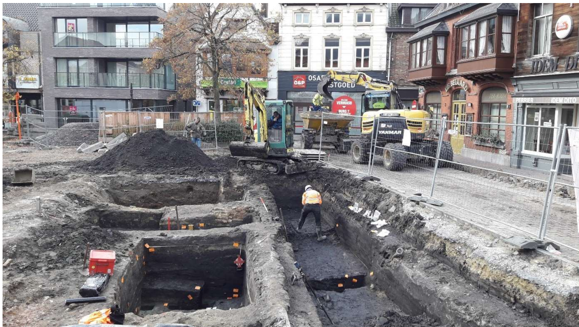
Figuur 5. Overzicht van werkput 4 met centraal een profielbank ter ondersteuning van een leiding.
