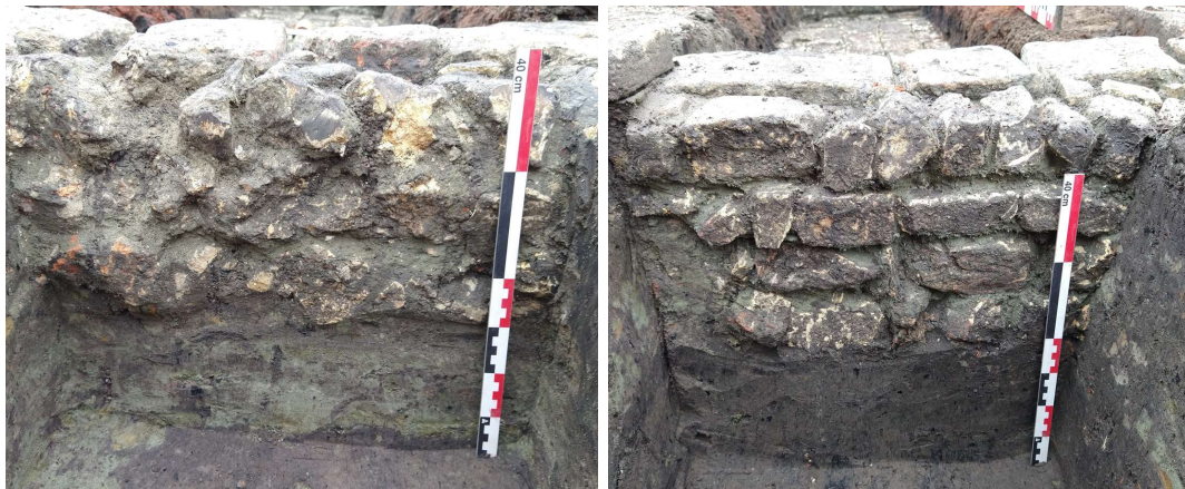
Figuur 13. Links: Buitenzijde van de westelijke muur (maximale diepte tot ca. 20. 6m TAW). Rechts: Buitenzijde van de oostelijke muur (maximale diepte tot ca. 20. 4m TAW)
