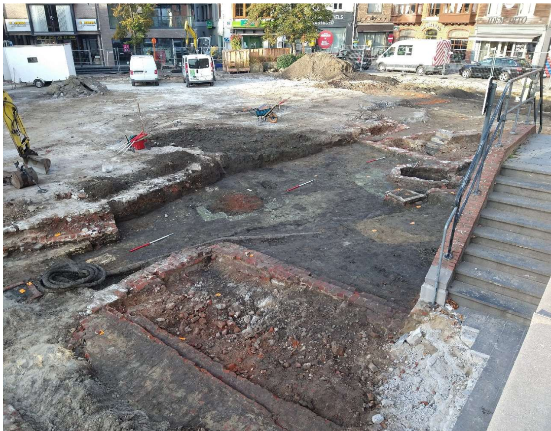
Figuur 3. Overzicht van werkput 6, vlak 2, gelegen net achter het Vrijetijds huis. Op de voorgrond een opgevulde kelder. Centraal het kruisvormige gebouwtje waarin veel verbrande leem aanwezig was.
