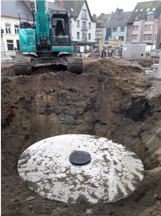
Figuur 6. De nieuwe geplaatste citerne.
