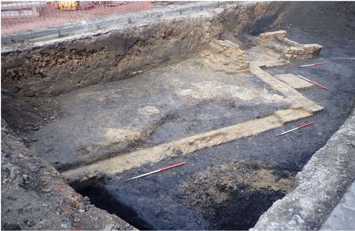
Figuur 40. Zicht op de funderingen in vlak 6.
