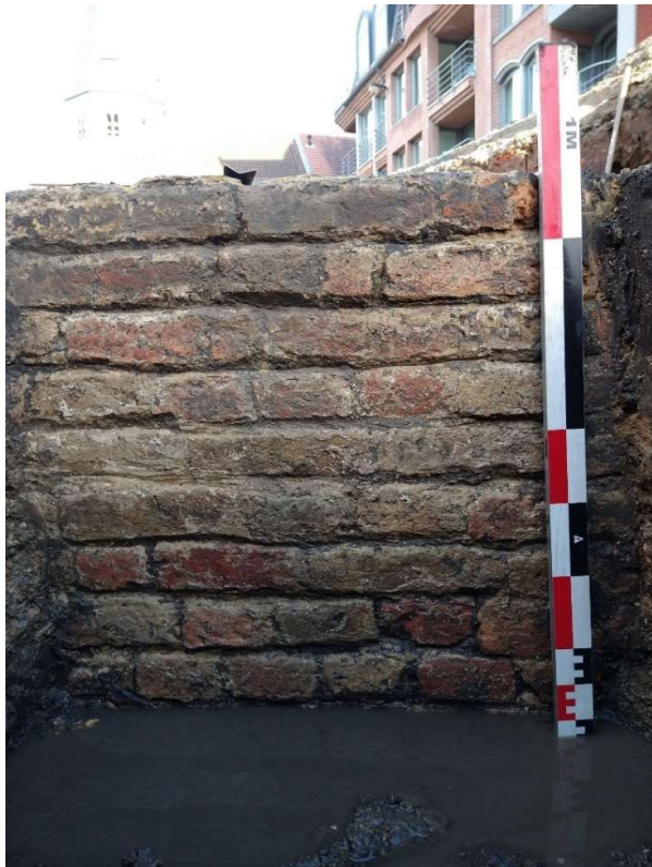
Figuur 45. Binnenzijde van het metselwerk van het gebouw. Dikte van de 10 lagen was 82cm.
