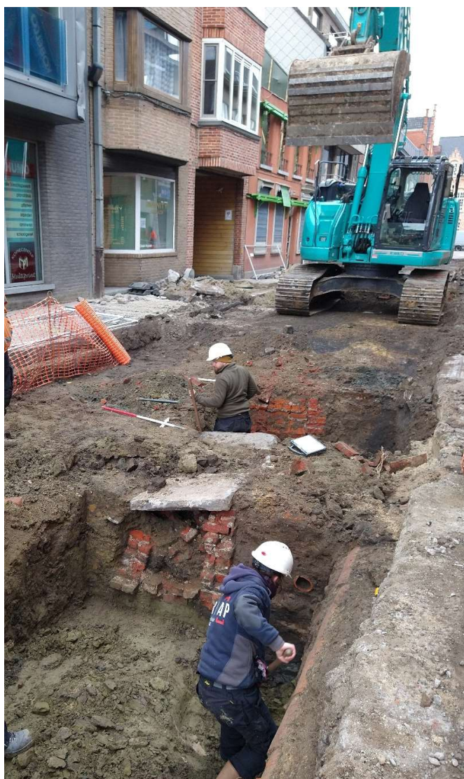
Figuur 1. Zicht op werkput 26. Centraal liep de oude riolering in baksteen.
