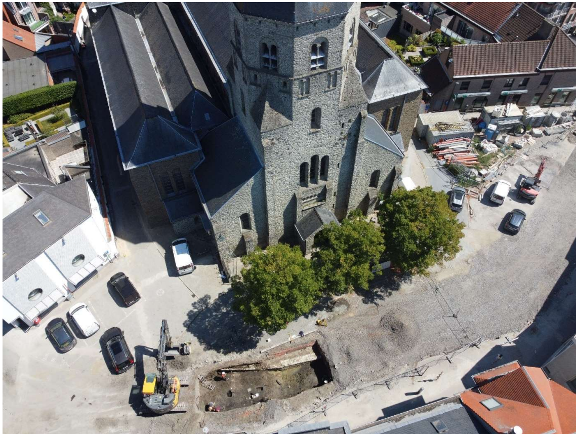
Figuur 7. Droneopname van de aanleg van werkput 22, voor de westzijde van de kerk. Het verloop van de middeleeuwse kerkhofmuur is er goed zichtbaar.
