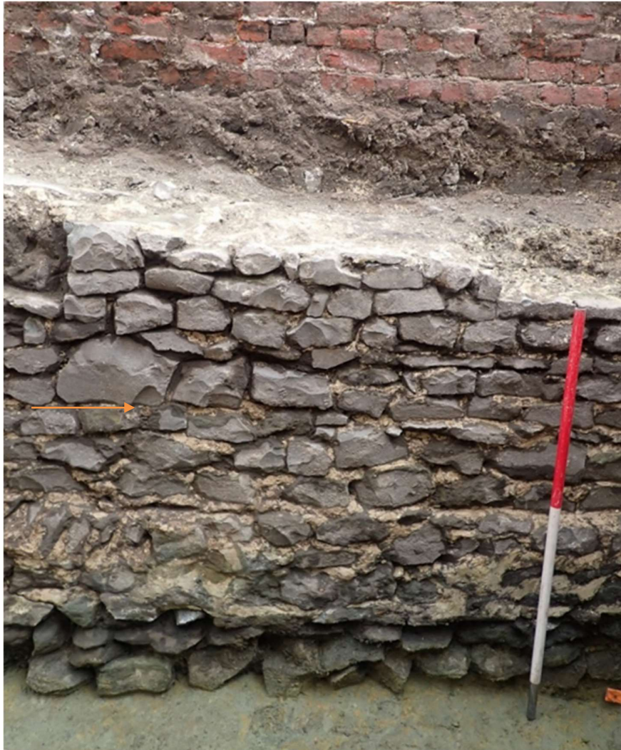
Figuur 60. Opbouw van de muur in velsteen (WP22). Er zijn duidelijk drie verschillende bouwlagen aanwezig. Bovenaan de foto een veel jongere muur in baksteen. De pijl duidt het veronderstelde toenmalig loopniveau aan (op 19,60m TAW).
