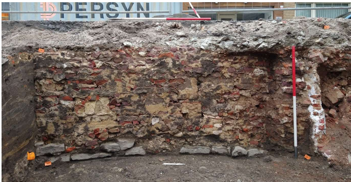
Figuur 57. Profiel P1402. Onder de slordig gemetste kelderdeur werden blokken natuursteen waargenomen (S1406). Deze bevonden zich in het verlengde van de muur in natuursteen, aangetroffen in WP17.
