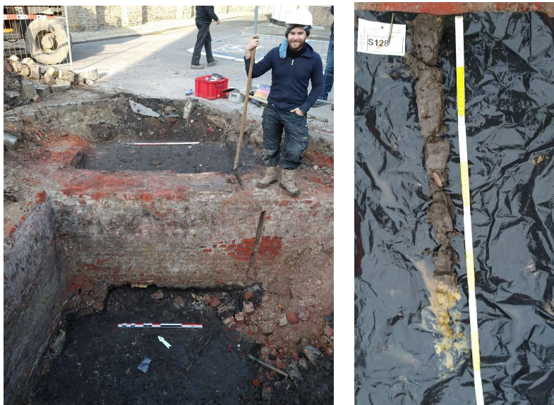
Figuur 10. Foto's genomen tijdens het vooronderzoek. Links een keldermuur met onder de opgebroken keldervloer enkele skeletresten. Rechts: een boring vanaf de laag onder de keldervloer gaf aan dat de natuurlijke bodem zich op ca. 3m onder het huidige maaiveld bevond.
