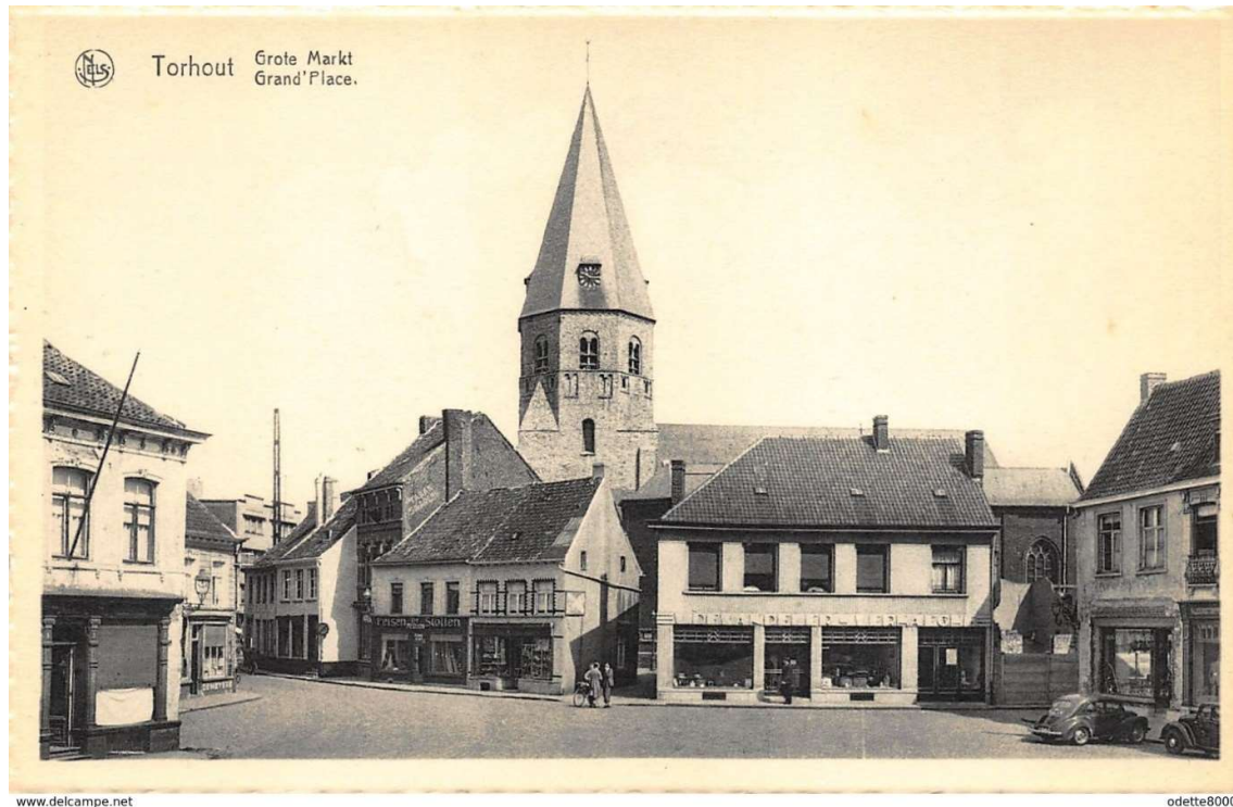
Figuur 52. Oude afbeelding van de huizen rondom de kerk (opnamedatum voor 1970). De funderingen en kelderverdiepingen kunnen worden gelinkt met de huisjes aan de voorzijde van de kerk (links op de foto).
