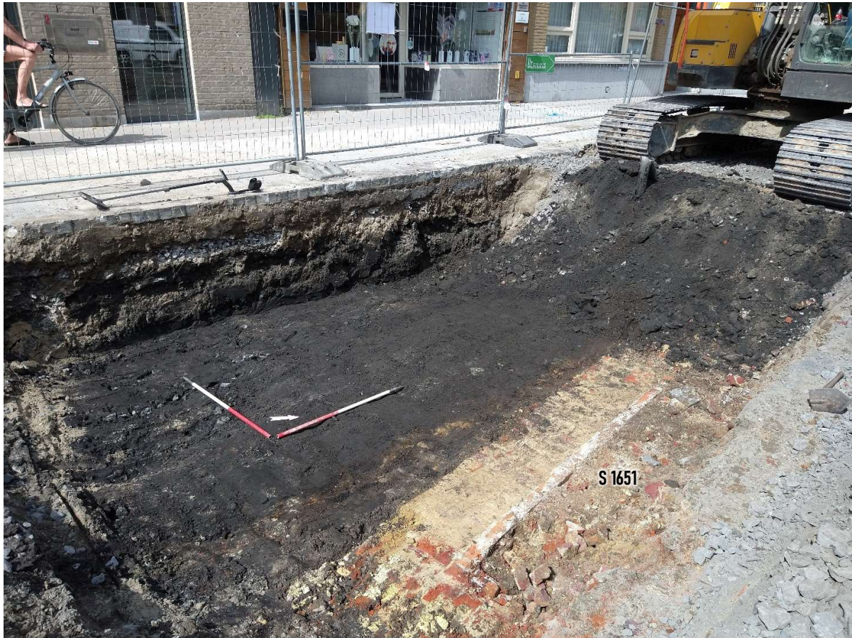
Figuur 57. Wegdek en voorgevel met kelder van WE02 in werkput 20.
