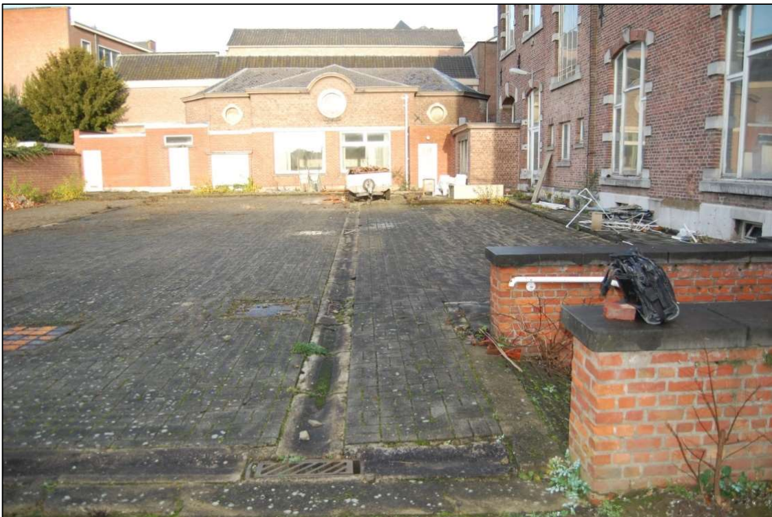
Afb. 7: Opname in noordwestelijke richting vanaf de zuidrand van het projectgebied: zicht op de bestaande verharding tussen het hoofdgebouw en de dwarsvleugel. Rechts de aanzet van het hellend vlak naar de kelder onder de bijbouw tegen de zuidgevel van dit hoofdgebouw (Stad Tongeren).
