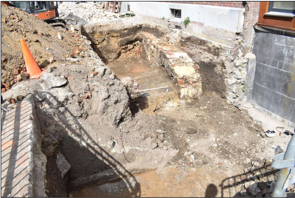
Afb. 11: Werkput 1 ter hoogte van de uitgebroken kelderinrit en toekomstige fietsinrit.
