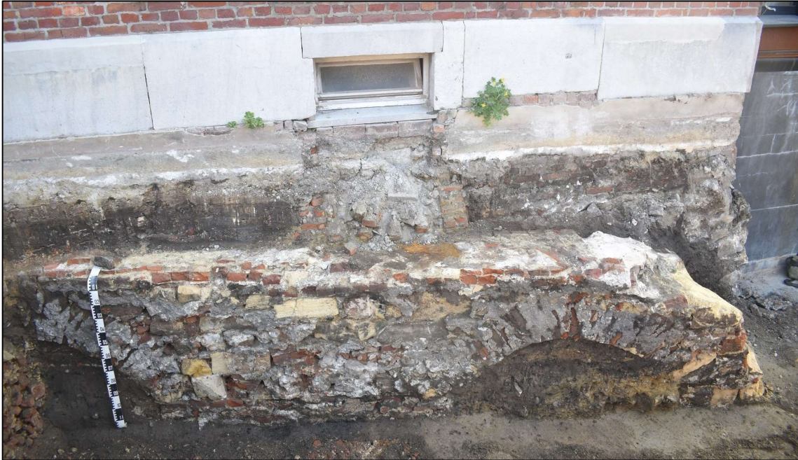
Afb. 49: Werkput 1, profiel 4 met S8: de funderingsmuur van het dormitorium.
