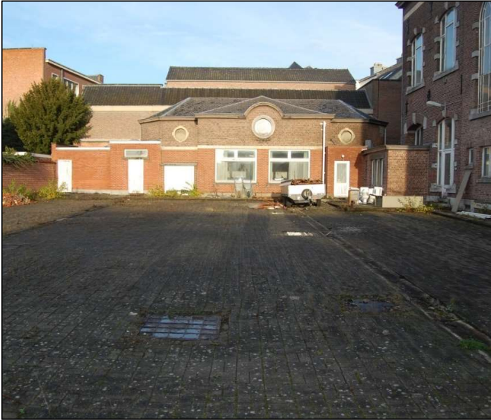
Afb. 5: Opname in noordwestelijke richting vanaf de zuidrand van het projectgebied: zicht op de recente aanbouwen nrs 1, 3 en 4 (oranje metselwerk) tegen de gevel van het koetshuis (Stad Tongeren).
