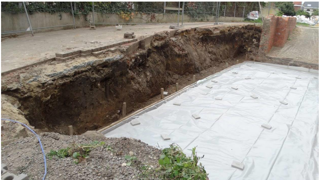
Zuidprofiel na afbraak bovenbouw.
