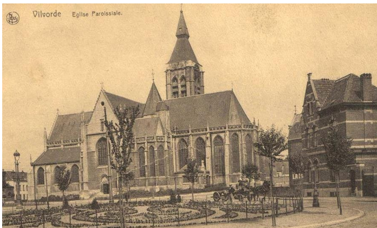
Figuur 13: De O.-L.-V. Van Goede Hoop-kerk aan de zuidzijde, na de herinrichting van het kerkhof in 1904 (© Heemkundige kring Vilvoorde).
