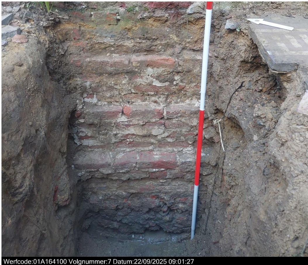
Figuur 75: Zicht op funderingsmuren S1 en S2 in inspectieput 7.
