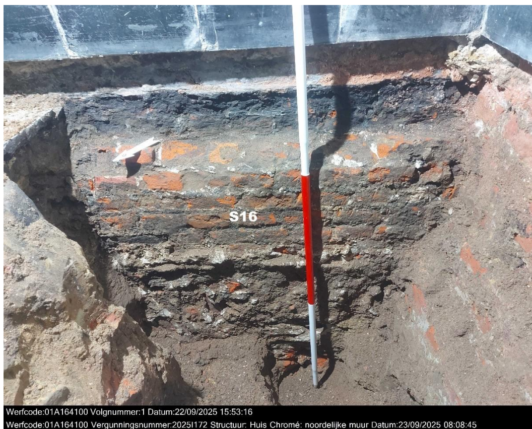
Figuur 69: Zicht op funderingsmuur S16 in inspectieput 2.
