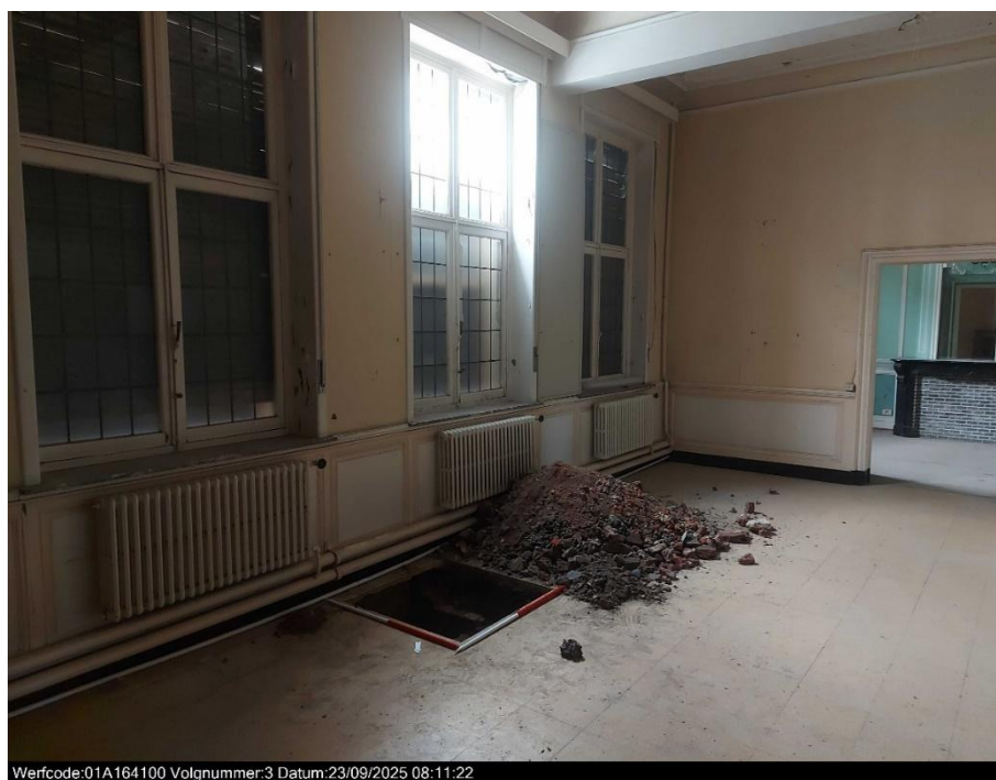
Figuur 71: Overzicht van de plaatsing van inspectieput 3 tegen de gevelmuur aan de Groeningestraat.
