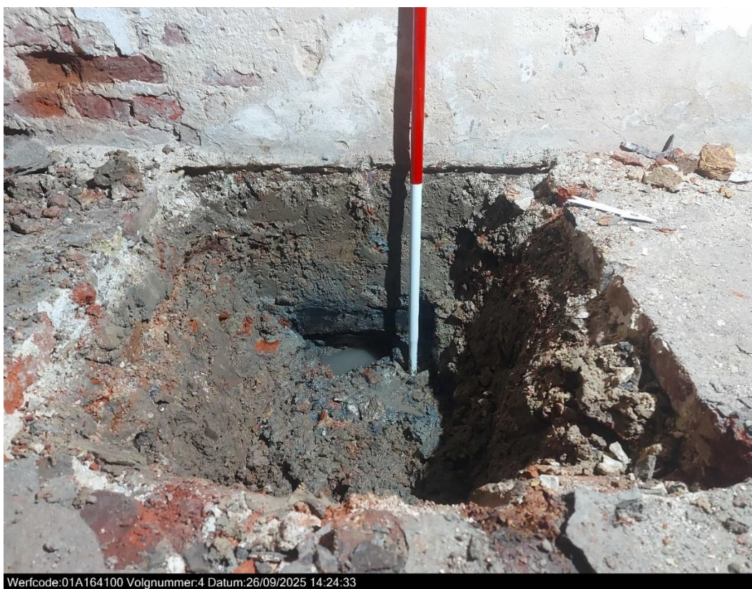
Figuur 76: Zicht op inspectieput 4 in de kelder van huis De Kroon.
