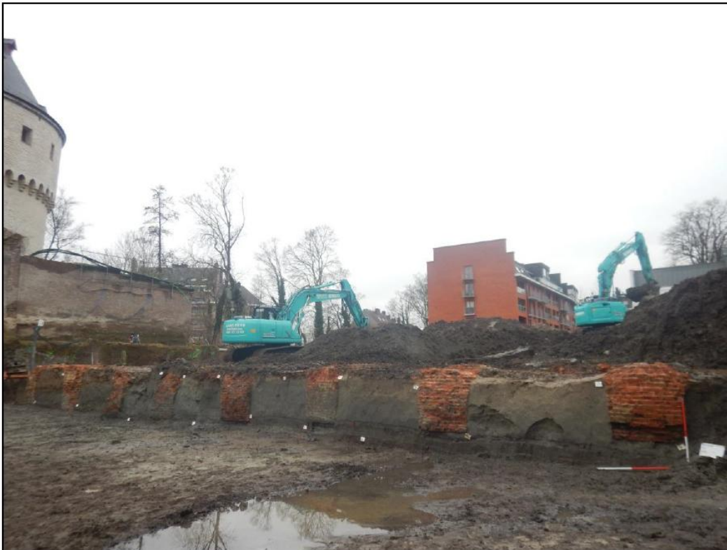
Figuur 53: Profiel 10: fundering van de stadsmuur gebouwd op stabiele varven (bron: ARNOUITS M., VINCENT R., 2020 p. 66, fig. 71)
