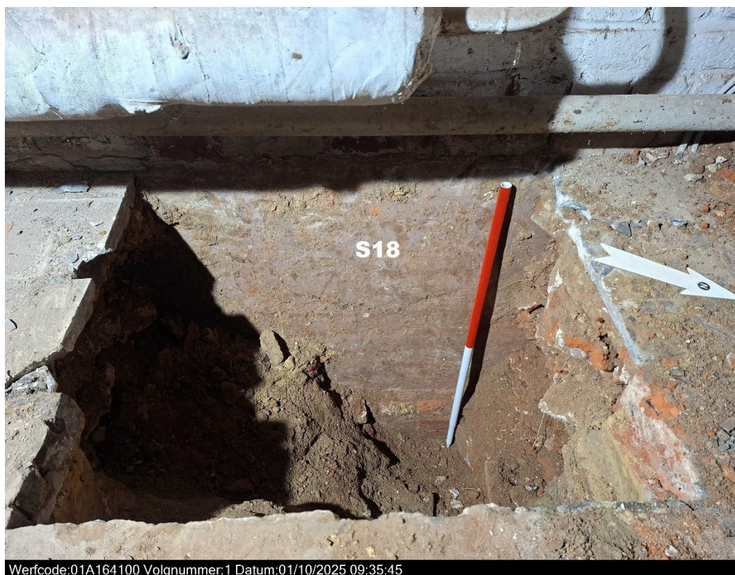
Figuur 65: Zicht op funderingsmuur S18 in inspectieput 1.
