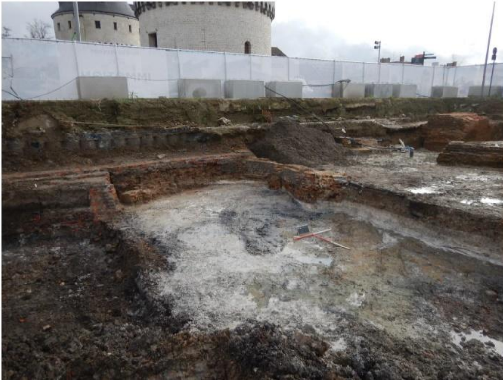
Figuur 59: Zicht op de fundering van de vermeende kalkoven (bron: ARNOUTS M., 2020. P. 46, fig. 48)
