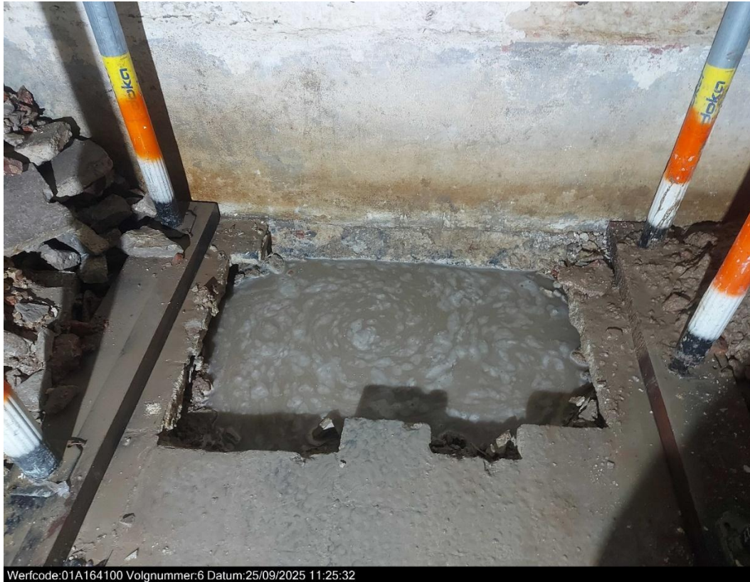
Figuur 77: Zicht op grondwater in inspectieput 6.
