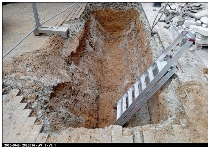
Figuur 2: Overzicht put na uitgraving stookolietank (mei 2025), zicht naar het noorden.
