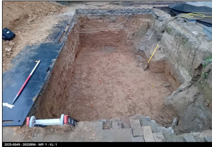
Figuur 3: Overzicht put na uitgraven uitbreiding hemelwaterput (oktober 2025), zicht naar het noorden.
