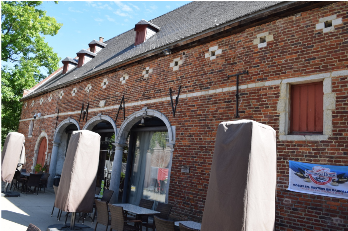
Fig. 3.14: Zicht op de muurankers M A V T en de steen met het jaartal 1657
