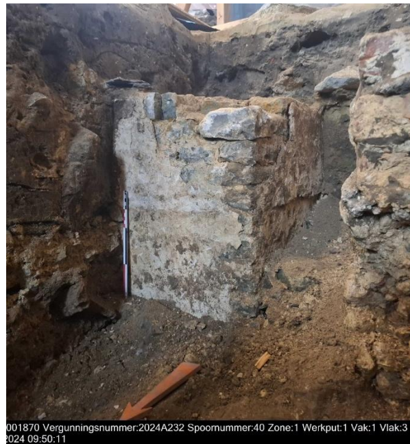
Figuur 45: Zowel aan de noordelijke binnenzijde als aan de westelijke - dus ook - binnenzijde is pleisterwerk te zien.
