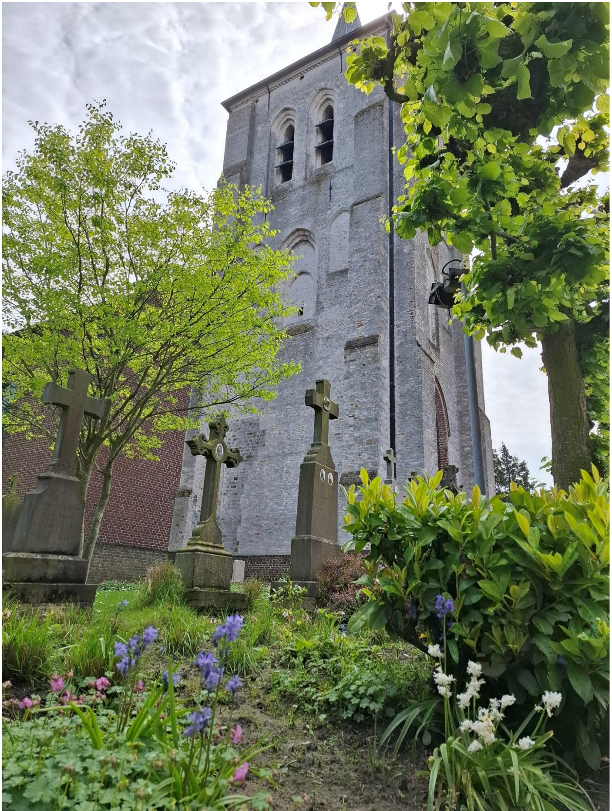
Figuur 4: Zicht op de toren met een deel van de noordwestgevel.
