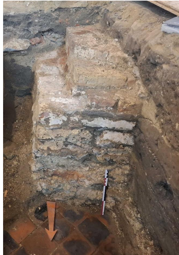
Figuur 55: Zicht op de noordzijde van de bakstenen pijler S31 in WP1. Bovenaan is witte bepleistering te zien.
