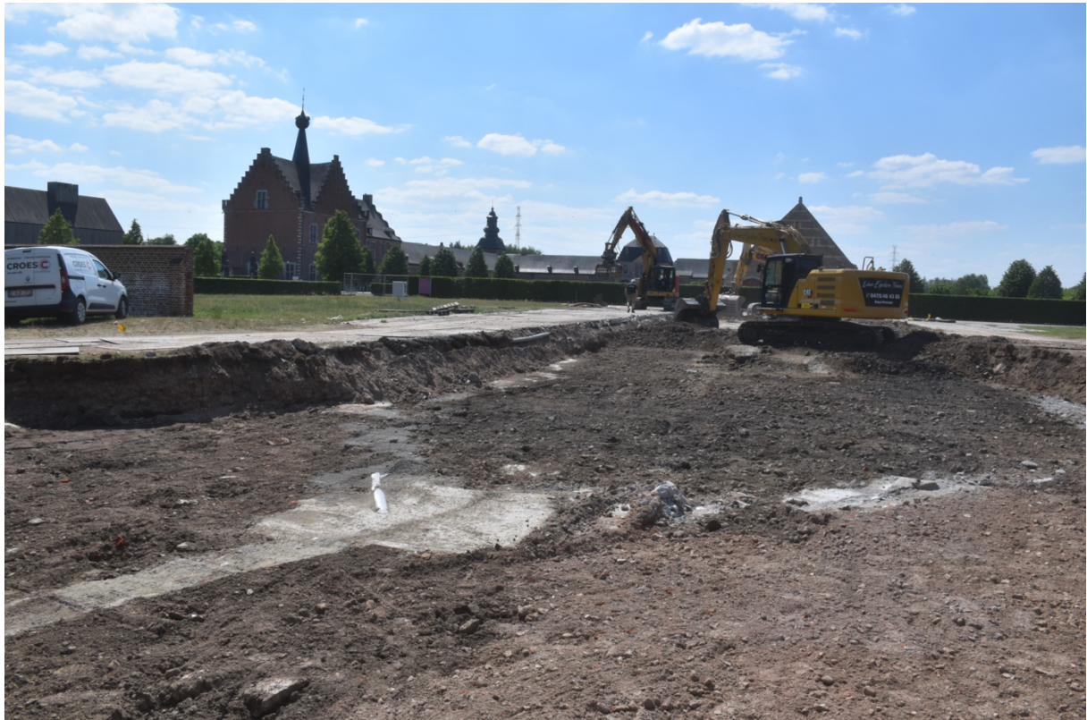
Fig. 3.14: Algemeen zicht tijdens de uitgraving van de bouwput met op de voorgrond de sleuven van de nutsleidingen uit 2015.
