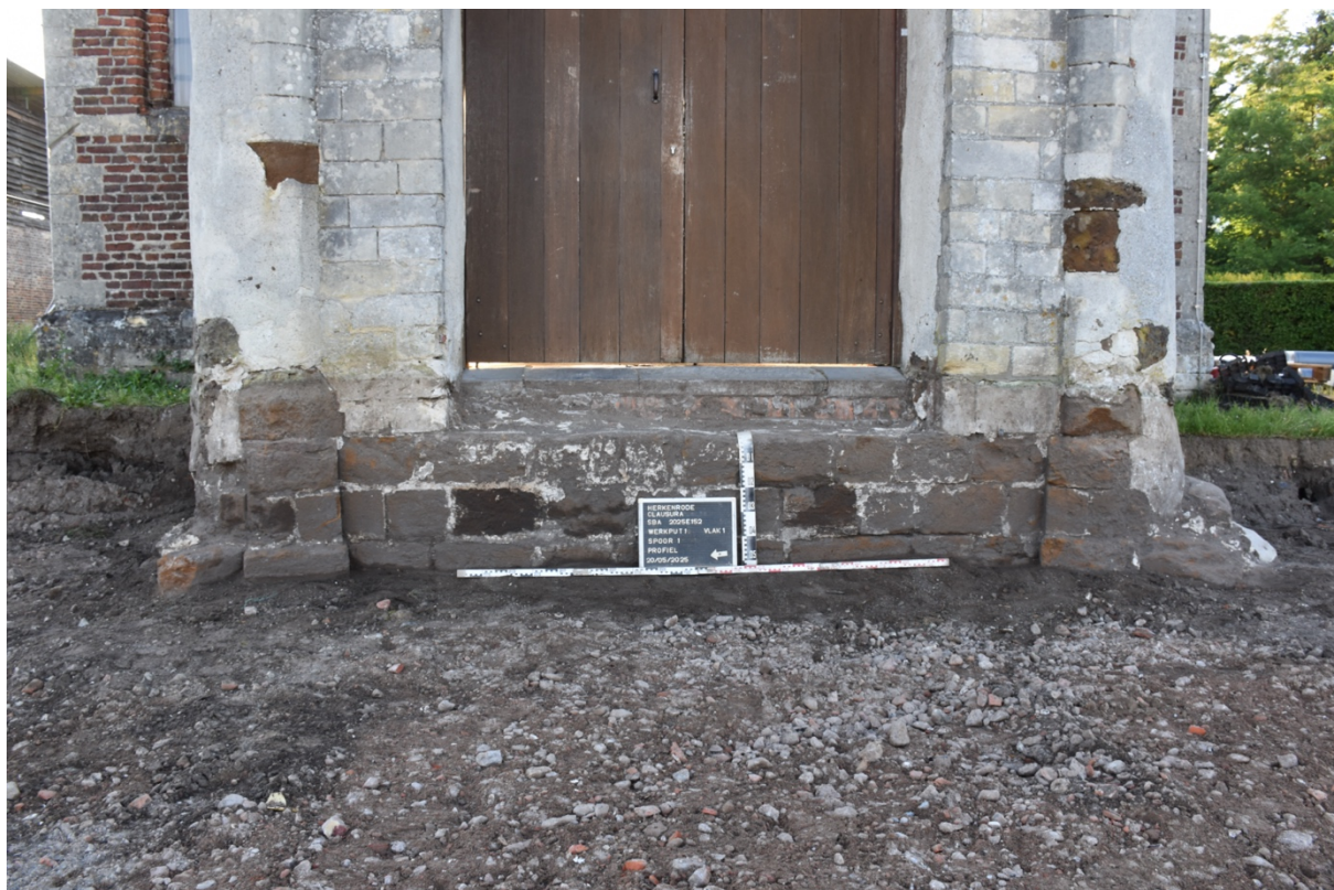
Fig. 3.15: De ijzerzandsteen fundering van de bestaande kapel (S1) met op de voorgrond de vulling van de opgravingsput met puin.
