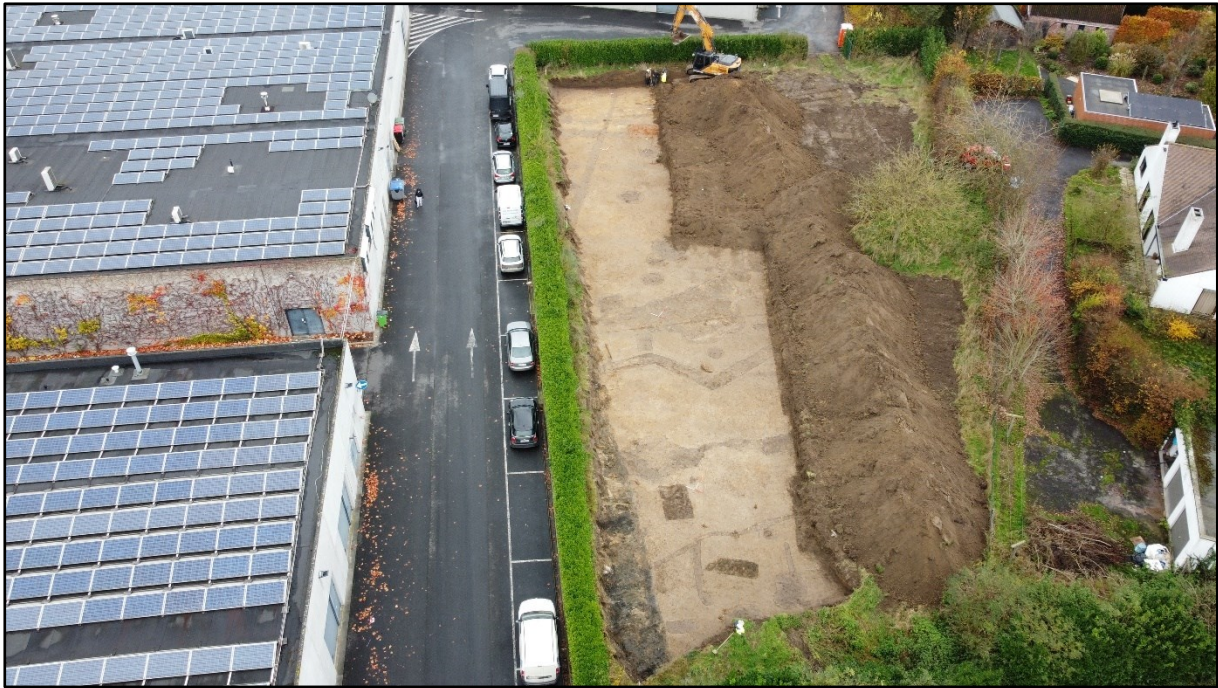
Figuur 5: Drone-opname van de westelijke helft van de opgravingszone (ABO nv 2024)
