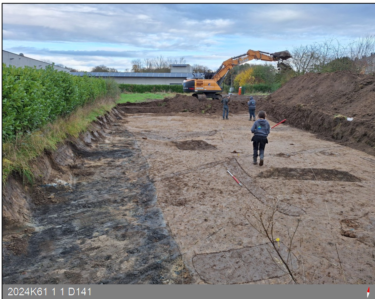
Figuur 12: Aanleggen van het vlak en archeologische registratie (ABO nv 2024).
