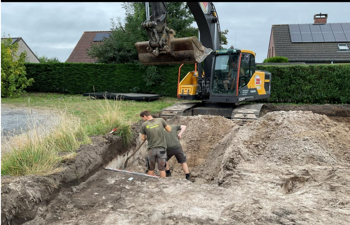
Figuur 20: fotografische opname van het plaatsen van een lokaal profiel t.b.v. bodemkundige waarnemingen.
