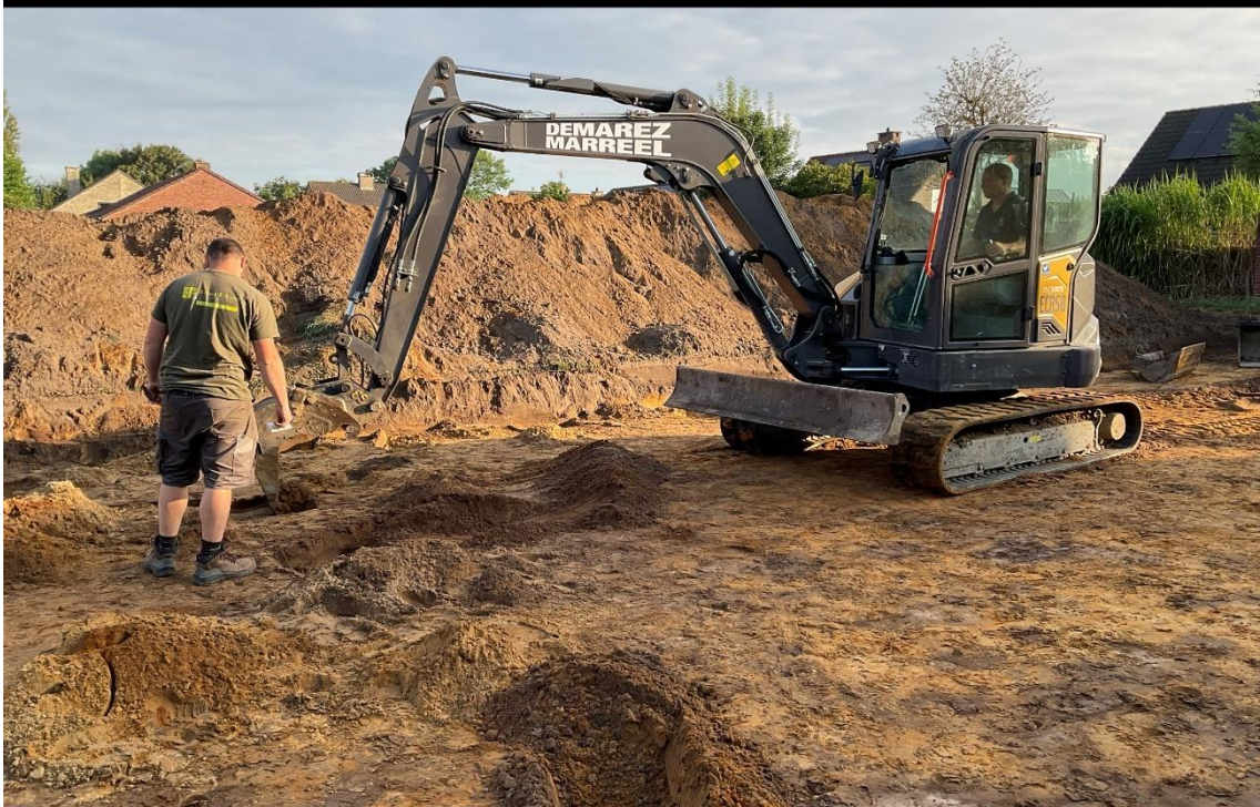
Figuur 21: fotografische opname van het machinaal couperen van de sporen door middel van een minigraver.
