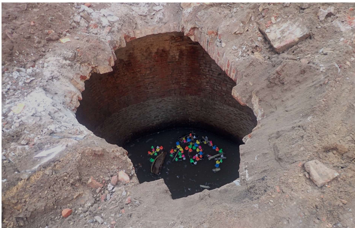
Figuur 58. De binnenzijde van de citerne na het verwijderen van de betonplaat.
