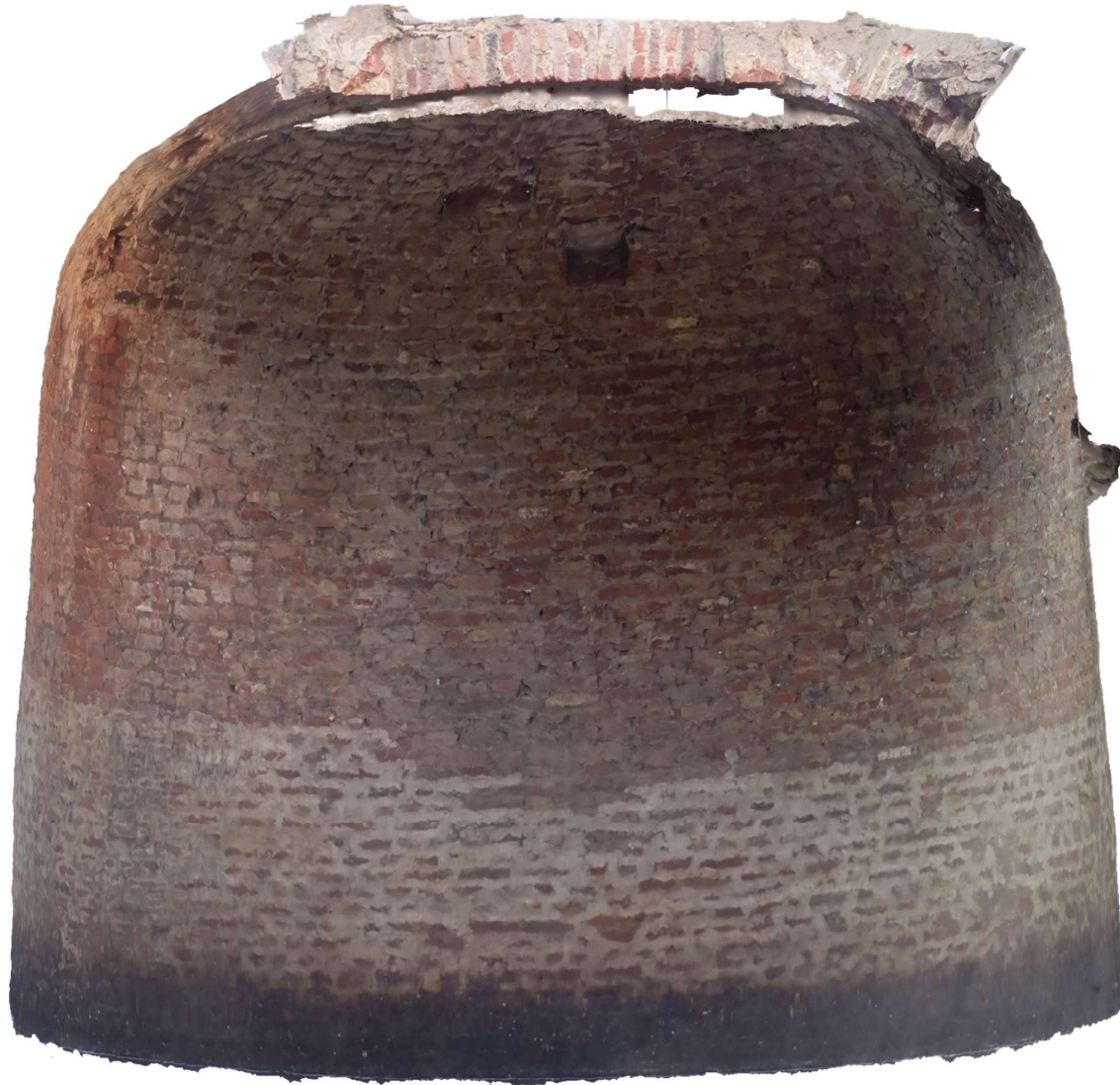
Figuur 59. Fotogrammetrische doorsnede van de citerne. De onderkant van het model komt overeen met de bovenkant van het water dat nog aanwezig was.
