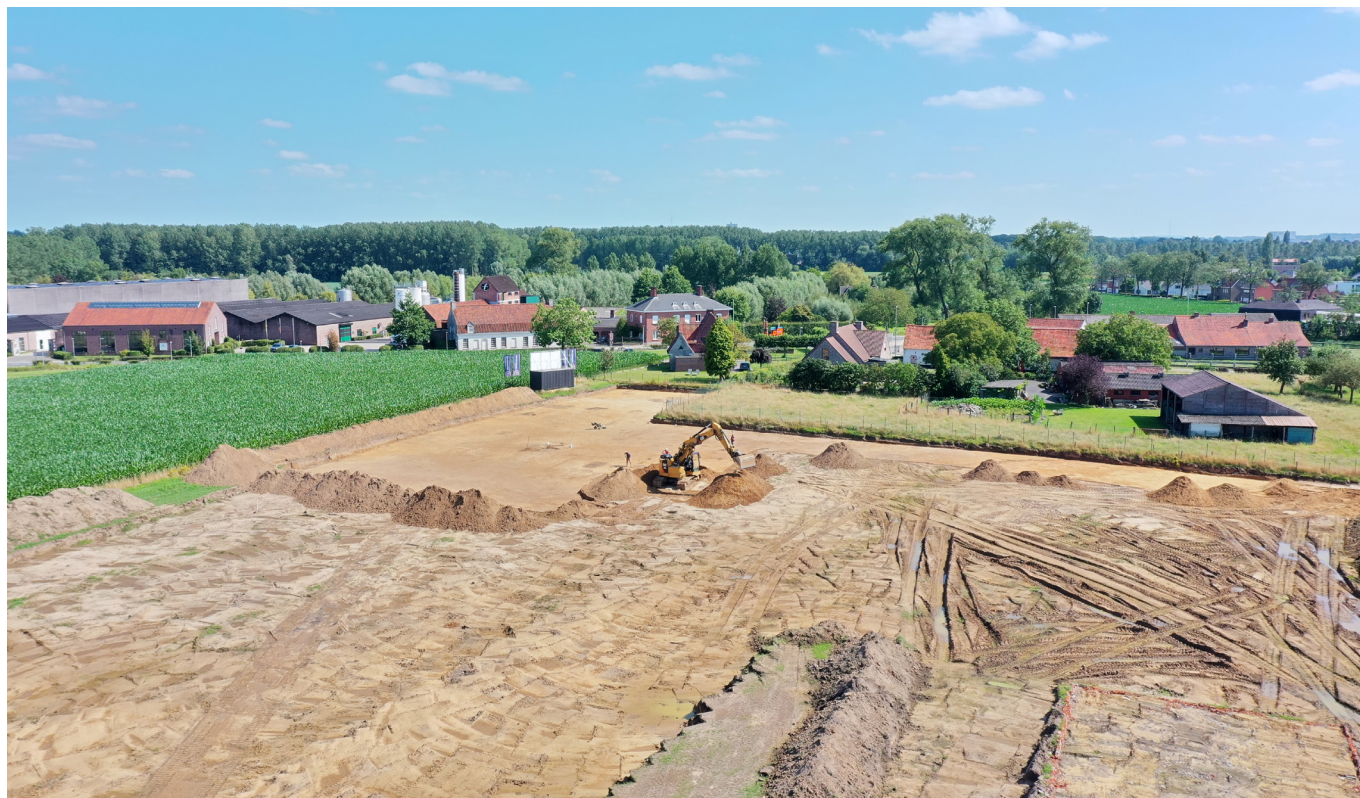
Figuur 24: Zicht op de toegepaste strategie voor het openleggen van het terrein
