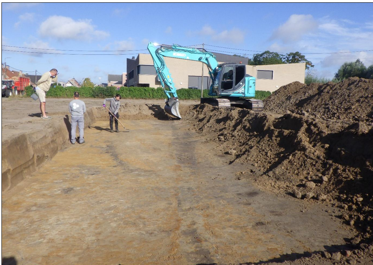
Figuur 8 Sfeerbeeld tijdens de aanleg.
