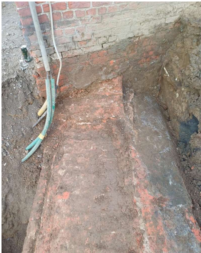
Figuur 66. Detail van de aansluiting van het muurwerk van S48 op de fundering van het bakstenen hoofdgebouw van het fort.
