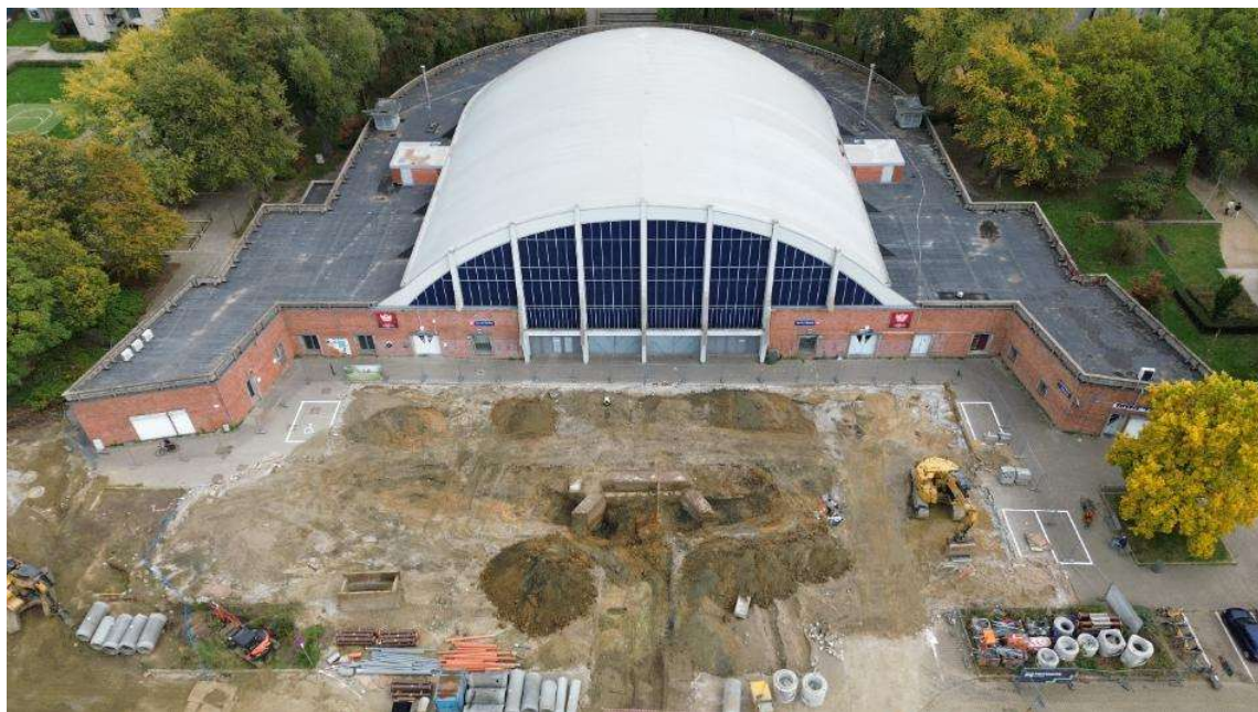
Figuur 3. Zicht op de site ter hoogte van werkput 3 en 4. Het nog aanwezige bakstenen gebouw op de site is het enige nog zichtbare bovengrondse element van het fort die bewaard is gebleven.
