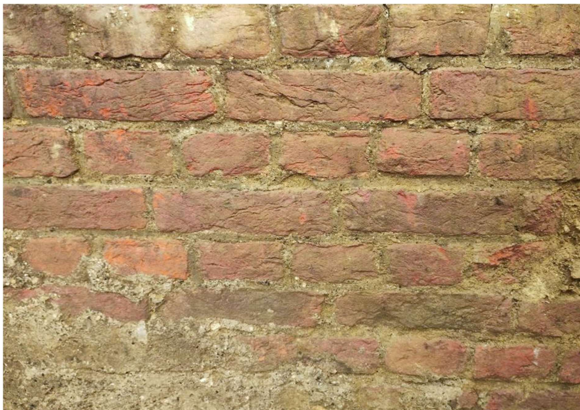
Figuur 59. Detail van het metselwerk in S35.
