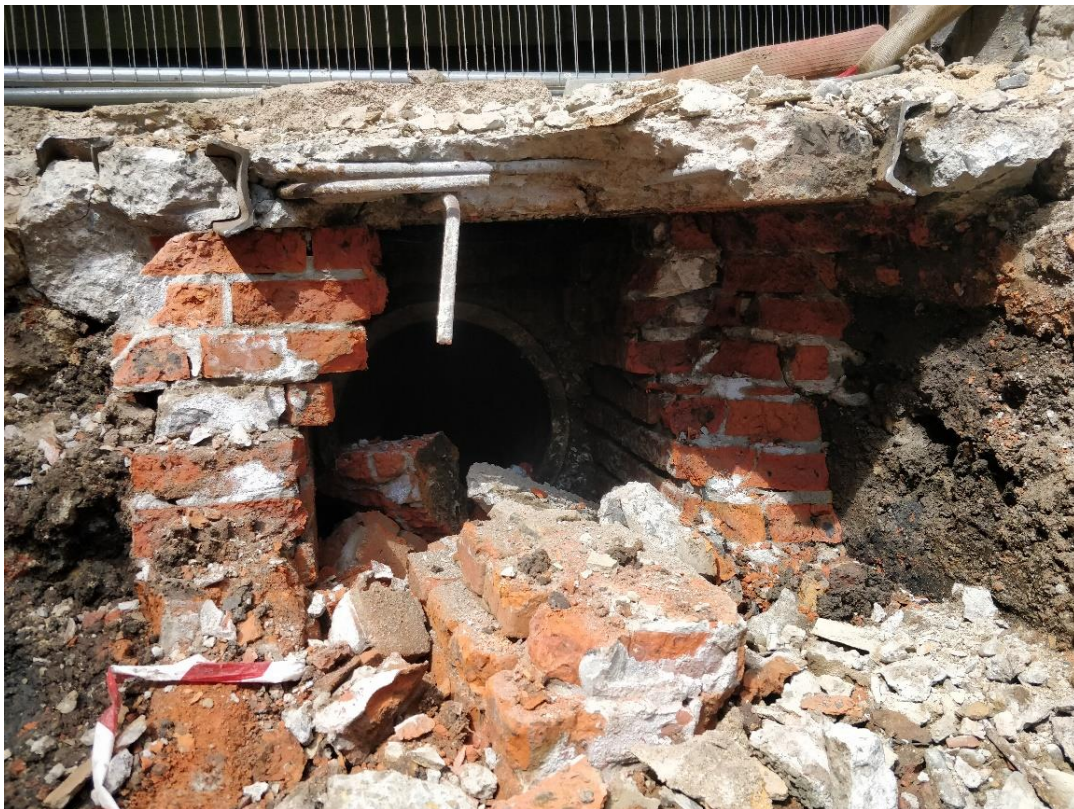
Figuur 21 Ingemetselde riolering
