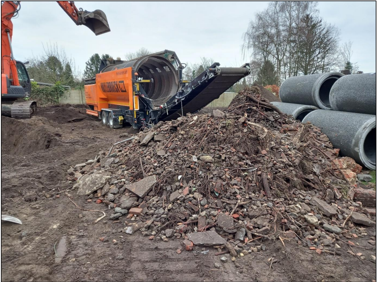
Figuur 10. Het zeven van de bovengrond in het noordelijke perceel.
