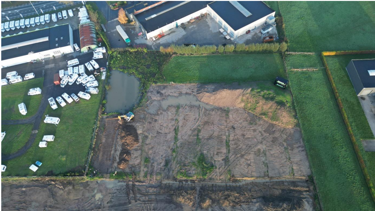
Figuur 18: Zicht op zone 1 met de waterpoel in het westen en de gestapelde containers in het noorden (Dronefoto © Monument Vandekerckhove nv).
