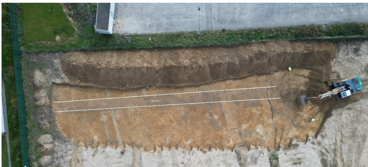
Figuur 76: Gracht 1 in werkput 1 van zone 2 vanuit het noordwesten (Dronefoto © Monument Vandekerckhove nv).
