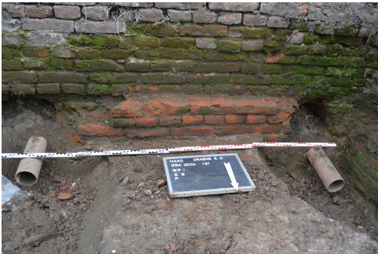
Fig. 2.14: Zicht op de fundering (S5) onder het meest noordelijke hoevegebouw.
