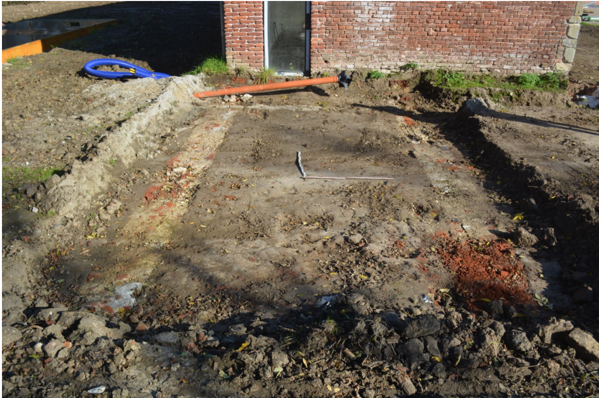
Fig. 2.15: Overzichtsfoto van WP1 waarop de twee muren S6 en S10 zichtbaar zijn.
