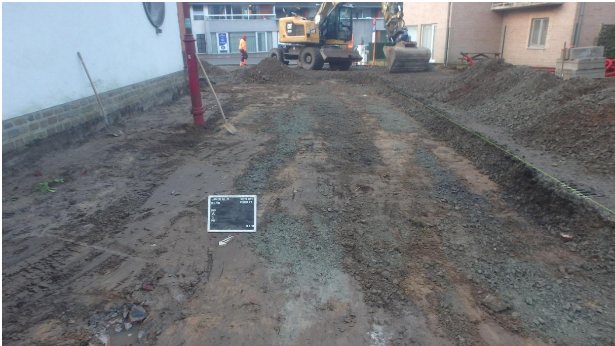
Figuur 7: Aanlegvlak oostelijke zone, gefotografeerd vanuit het noorden (@BAAC)
