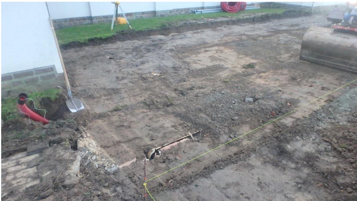
Figuur 6: Aanlegvlak oostelijke zone met zicht op riool, gefotografeerd vanuit het noordwesten (@BAAC)
