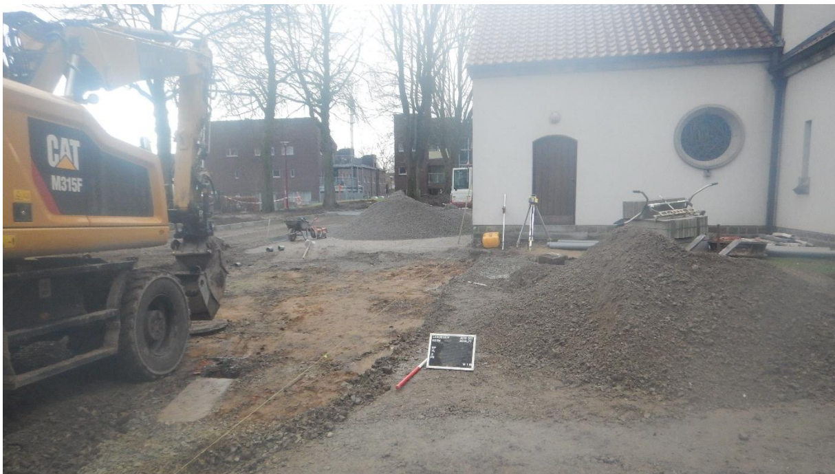
Figuur 8: Aanlegvlak oostelijke zone, gefotografeerd vanuit het zuiden (@BAAC)
